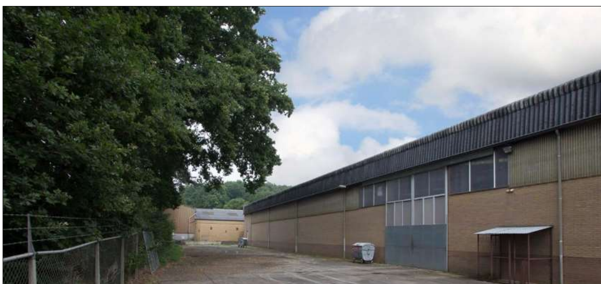
Figuur 9: Zicht op deellocatie B vanaf de Heidebaan
