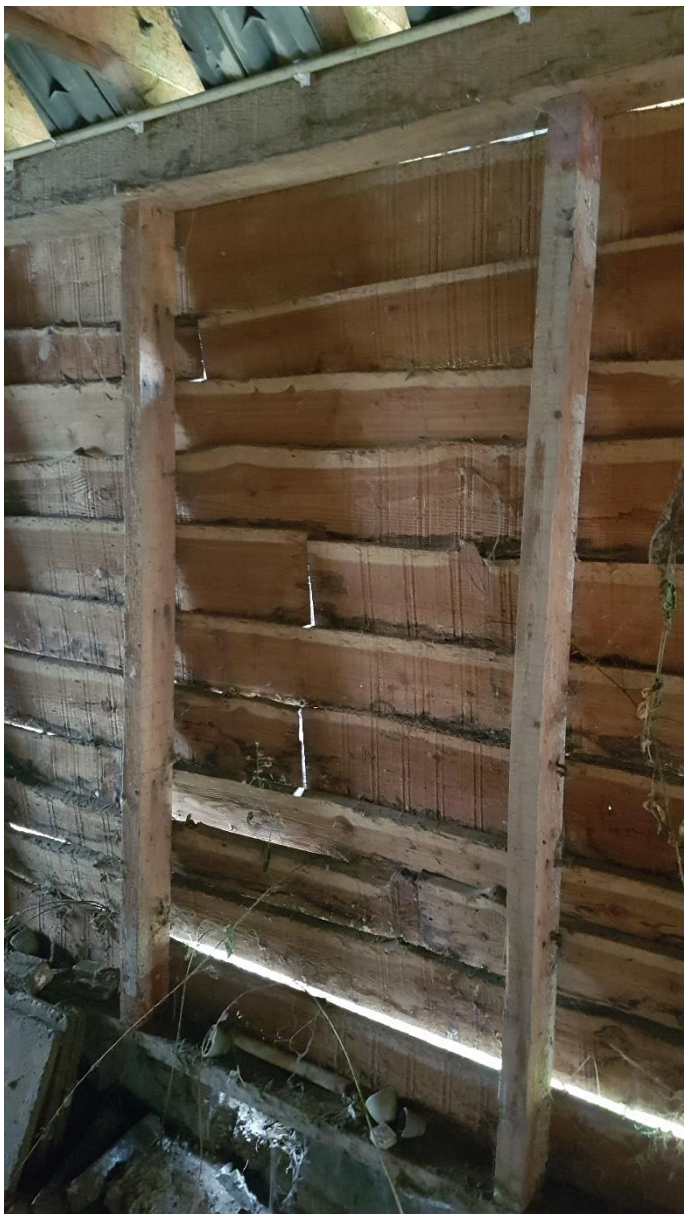
Foto 19: Kieren tussen de gepotdekselde houten muren van de kapschuur.
