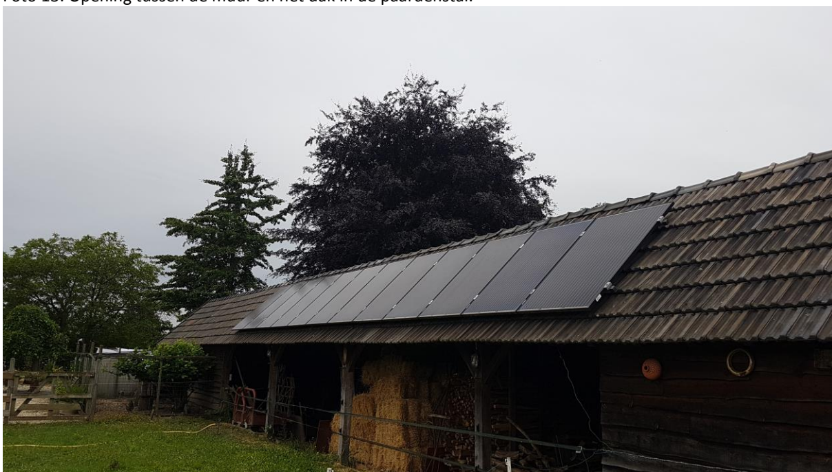
Foto 14: De voorkant van de kapschuur met de zonnepanelen op het dak en links de aangebouwde kippenren. In de kapschuur de opslag van hout en stro.
