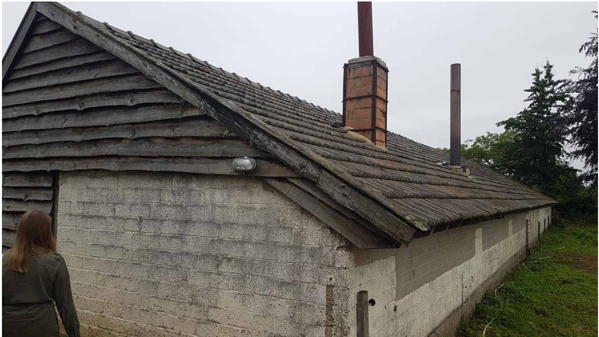
Foto 15: De achterkant van de kapschuur met schoorstenen.
