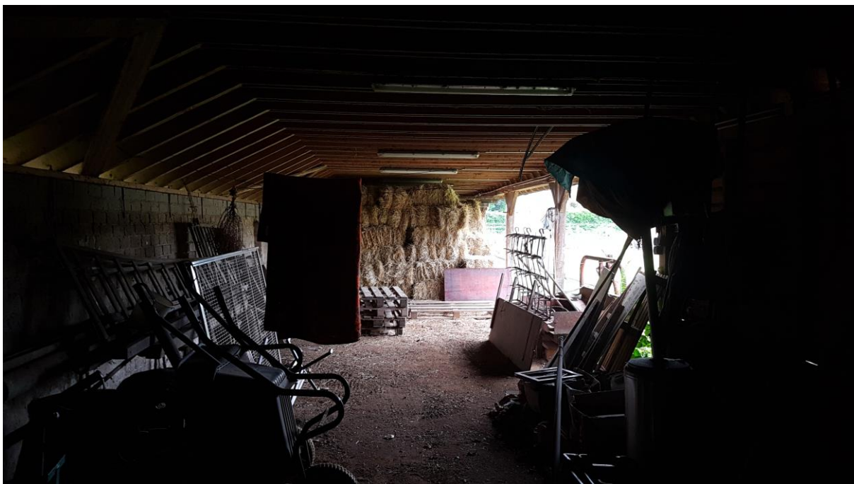
Foto 17: Overzichtsfoto van de binnenkant van de kapschuur met op de achtergrond de stro opslag.
