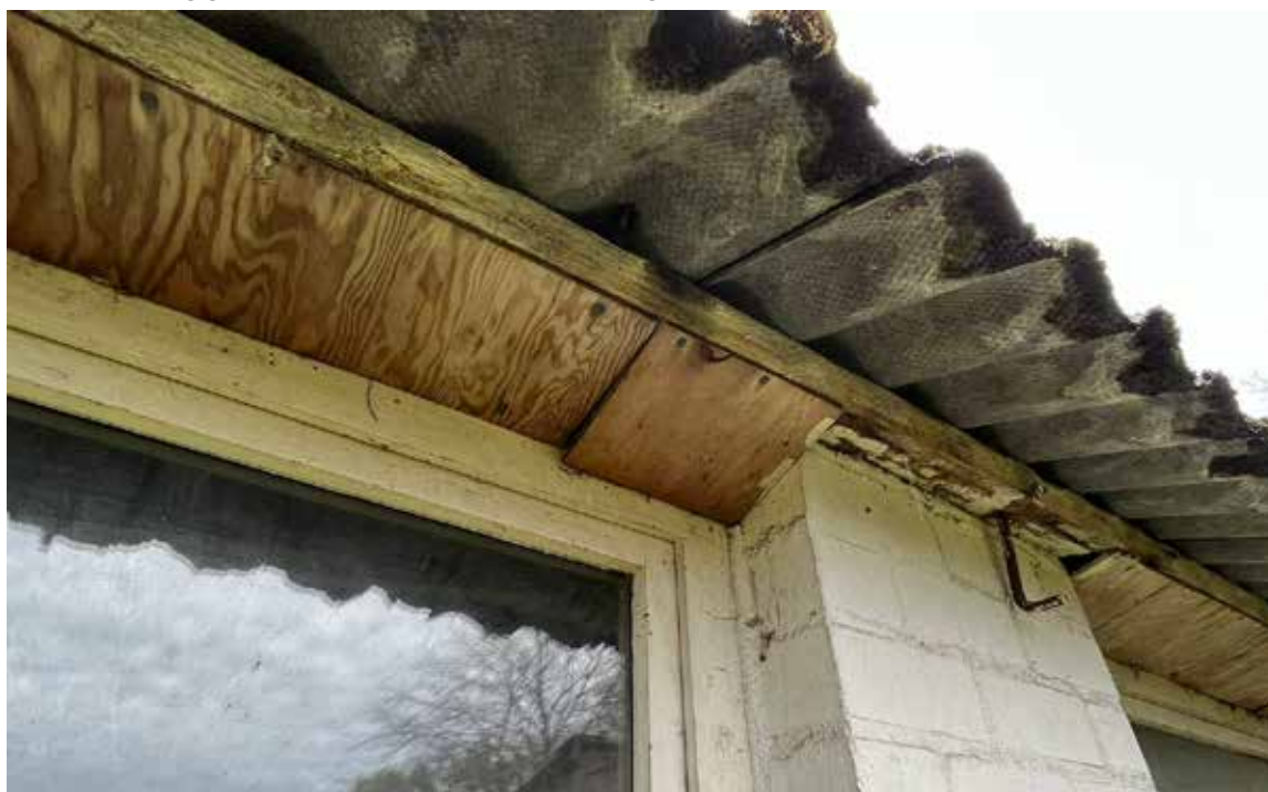
Figuur 2: De locatie waar ten tijde van de quickscan nestmateriaal was aangetroffen.
