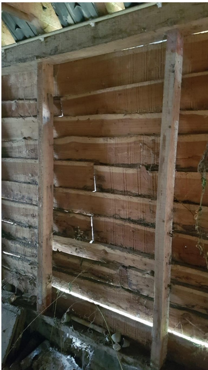
Foto 19: Kieren tussen de gepotdekselde houten muren van de kapschuur.
