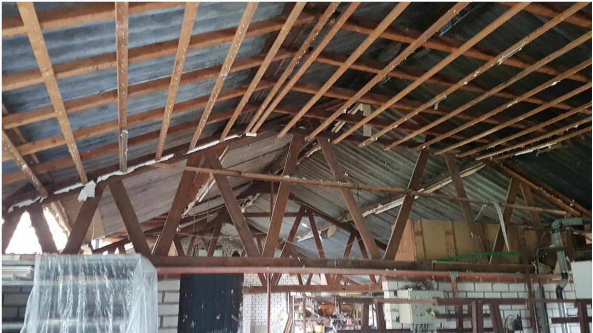
Foto 6: Binnenkant van de bedrijfsloods. Het dakbeschot is reeds verwijderd en de asbest dakplaten zijn zichtbaar.
