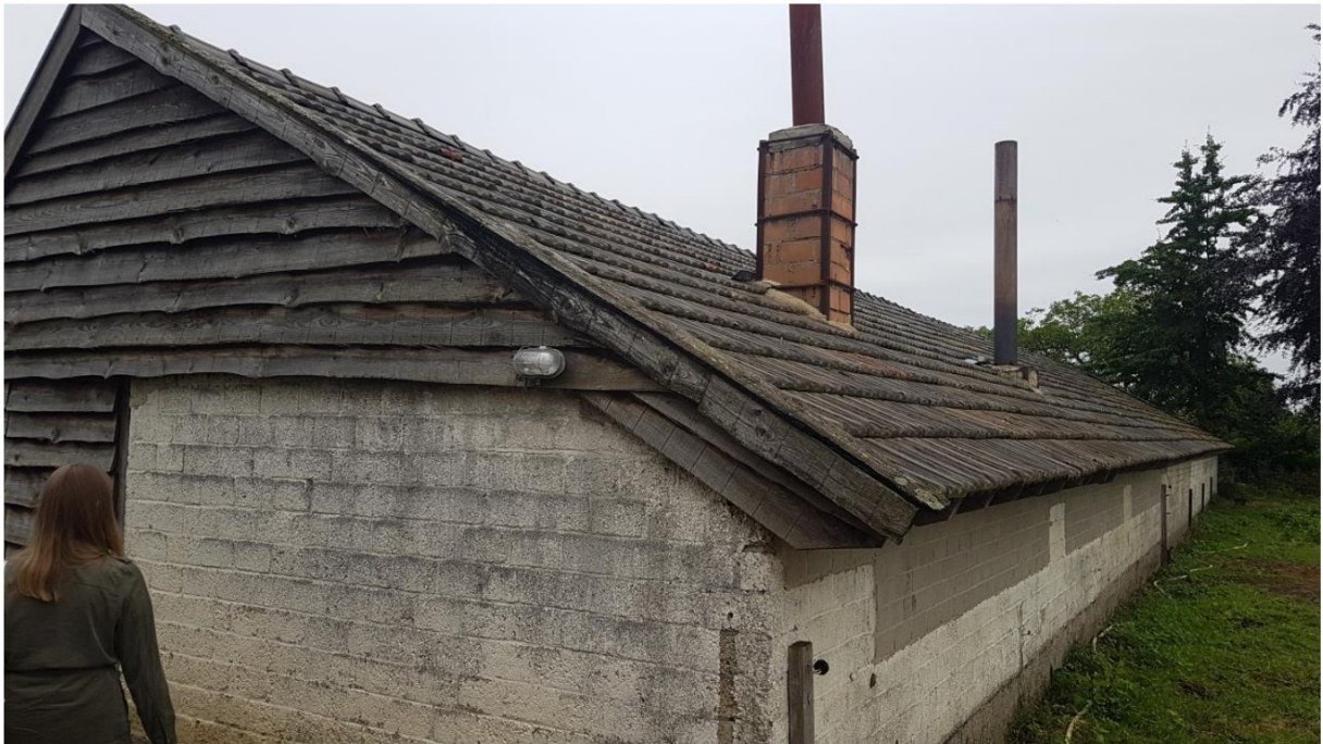
Foto 15: De achterkant van de kapschuur met schoorstenen.
