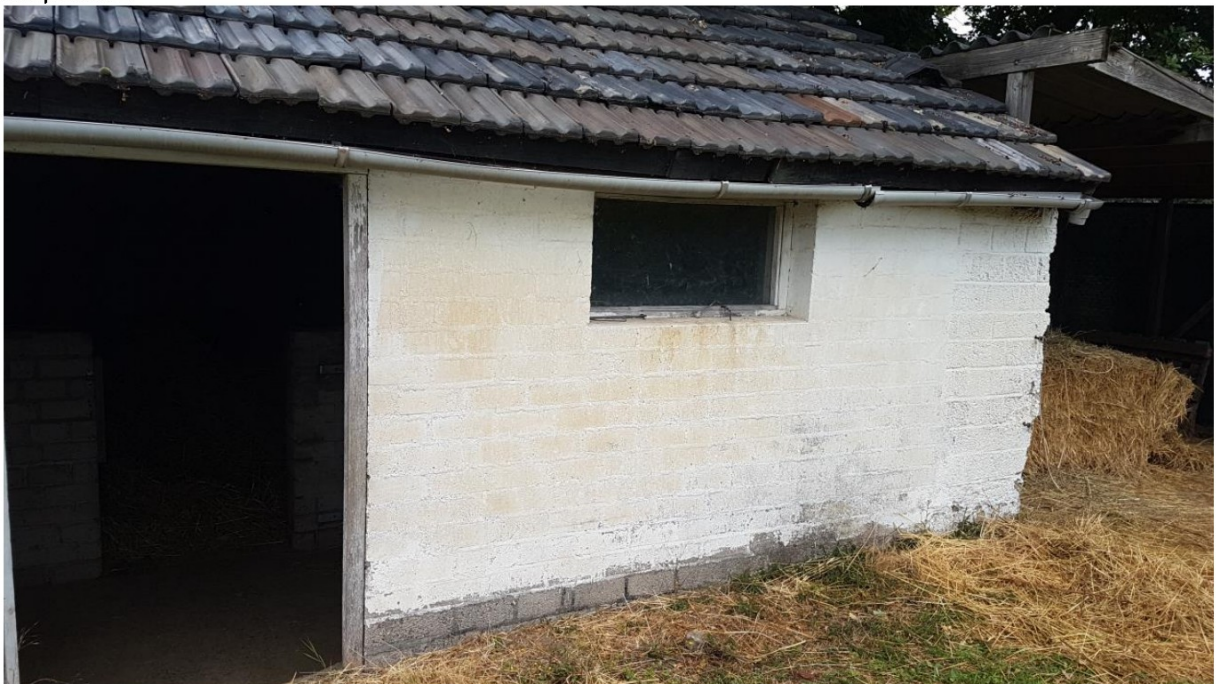
Foto 10: De voorkant van de paardenstal (oostkant) met rechts de houten overkapping en opslag van stro.
