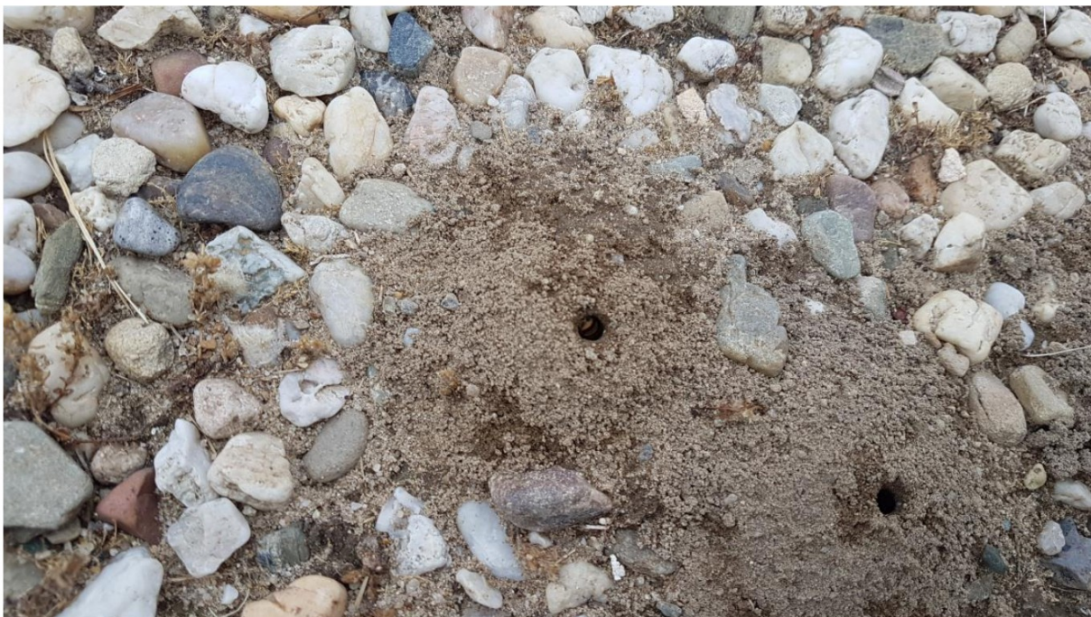
Foto 20: Bijennesten bij de voordeur van de bedrijfsloods.
