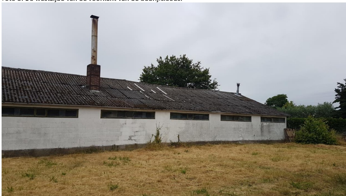
Foto 4: De oostzijde van de voorkant van de bedrijfsloods met de schoorstenen van de ovens.
