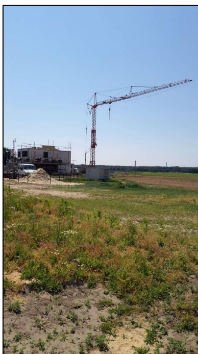
Afb.6 – Bouwwerkzaamheden, transformatorhuis en hekwerk "Asenray".
