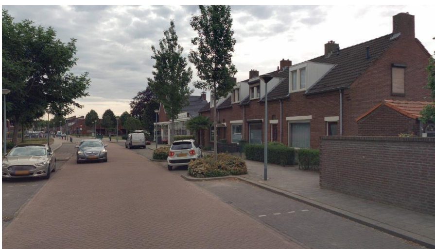
Woningen Kempweg 16 t/m22
