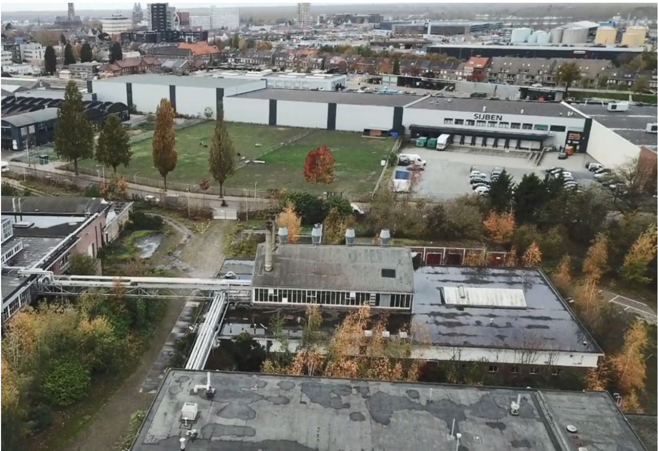
Figuur 29 Het ketelhuis en de buizenstraat over de hoofdlaan die een verbinding vormt met de kastenfabriek.
