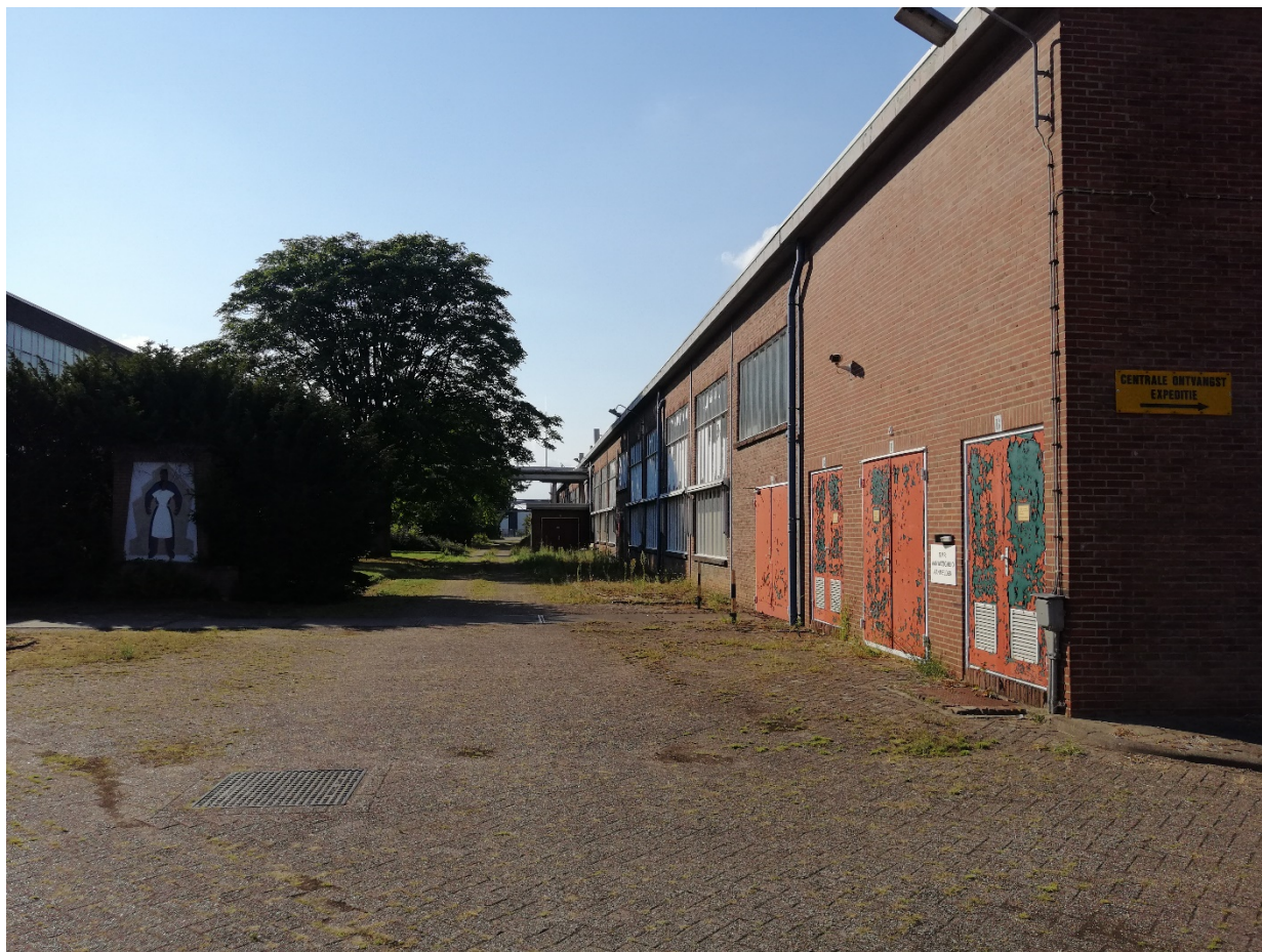
Figuur 25 De entree van de industriële boulevard met op de voorgrond het kunstwerk van Boessen. Beeldbepalend voor deze hoofdlaan zijn de buizenstraten.
