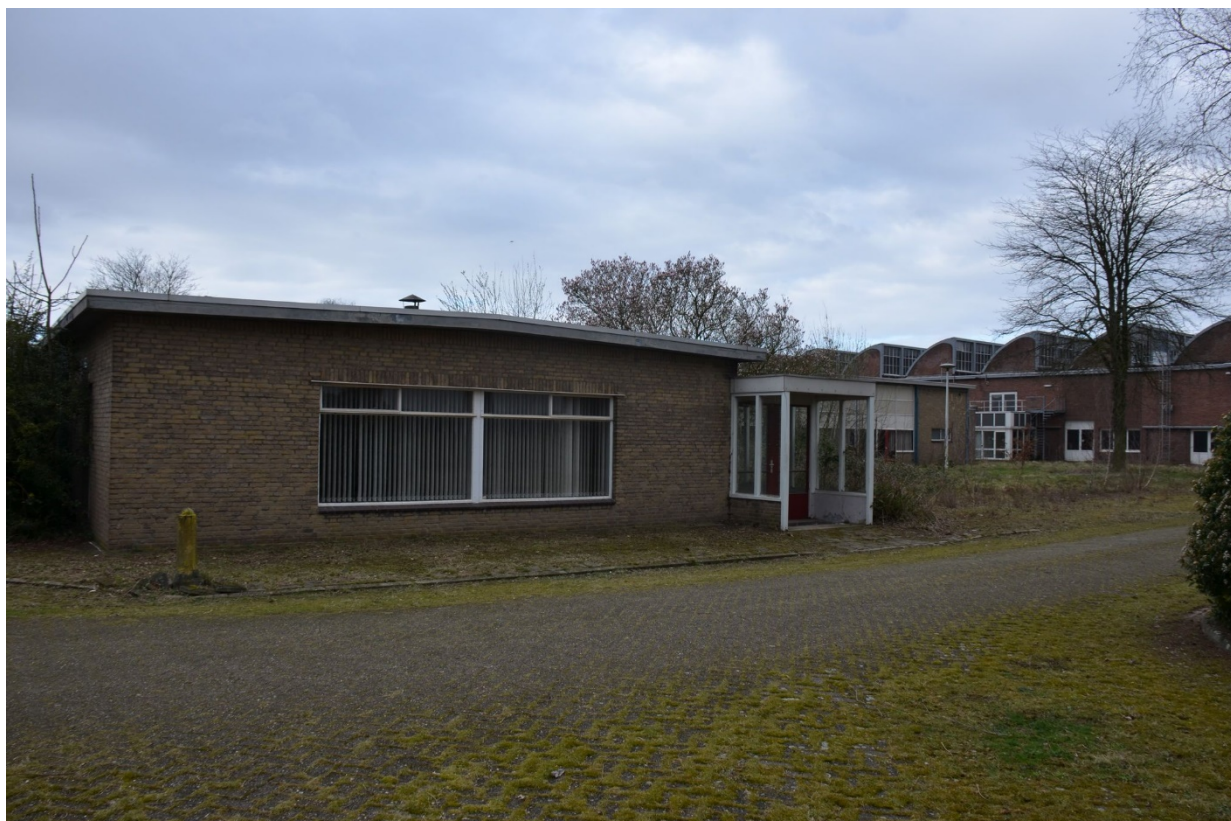
Figuur 16 Rechts bevindt zich de ingang van de kantine, de ruimte op de voorgrond betreft de personeelswinkel (Foto uit het archief van Peter Daamen, 2021).
