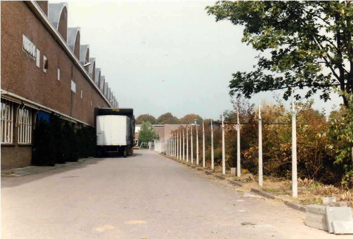
Figuur 17 Het terrein met Gebouw C werd in 1988 fysiek gescheiden van het voormalig Philipsterrein na de verkoop aan de Italiaanse firma Bagnatica rond 1986 (Foto uit het archief van Peter Daamen, 2021).
