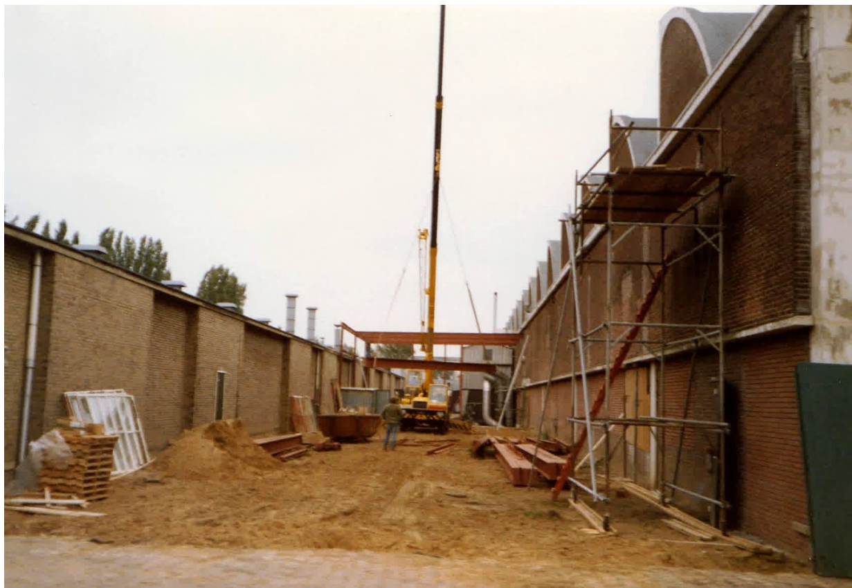
Figuur 15 Gebouw C wordt verbonden met de aanbouw ten westen van de fabriekshal in 1988 (Foto uit het archief van Peter Daamen, 2021).
