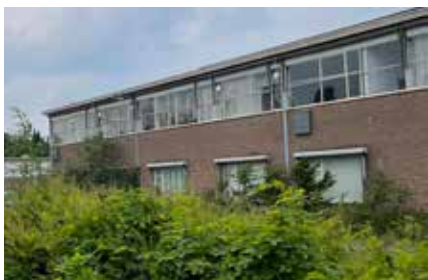
Hal P bakstenen basement, met doorlopende raampartijen op de 1ste verdieping (buiten plangebied)
