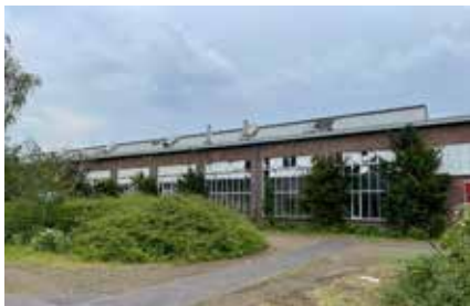
Hal met 3 sheddaken in langsrichting (oost-west)
