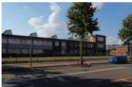
Kenmerkende sheddaken 'De zaagtand' hal L met accent op het einde van de Portiersloge
