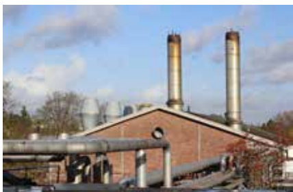
Schoorstenen en buizenstraten van het Ketelhuis
