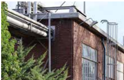
De oudste hal, met de originele hoofdconstructie die een lichte twist maakt in west) het grid tov de andere gebouwen.
