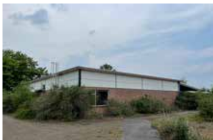
Voormalige brandweerkazerne (buiten plangebied)
