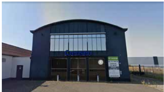
De karakteristieke hallen (Creusen) aan de Philipslaan
