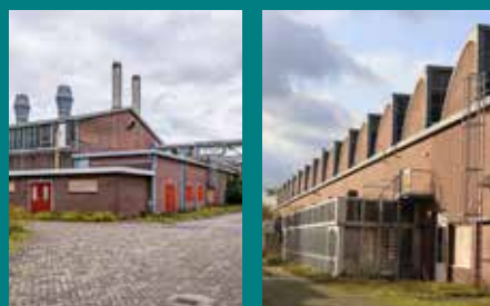
Industriële hallen Bruin getinte baksteen, zadeldak/sheddak
