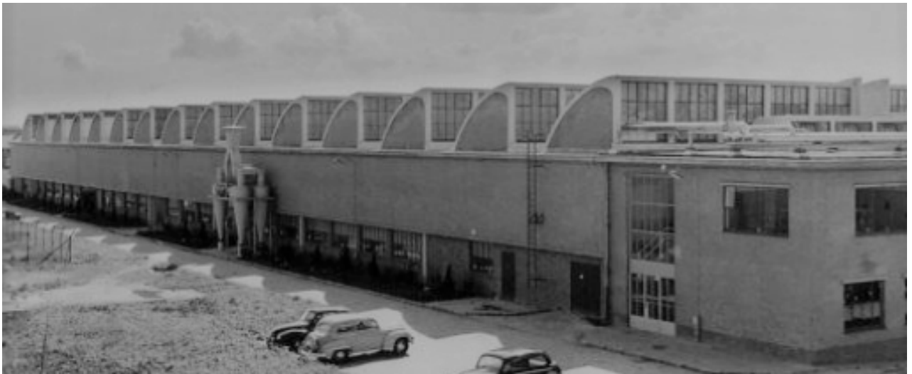
Gebouw C, 1952 met sheddaken opgebouwd uit betonnen schaalementen
