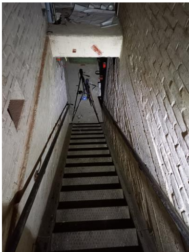
Foto 10: Meetpositie hal C, kelder (onder maaiveld)
