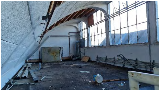
Binnen gebouw C
