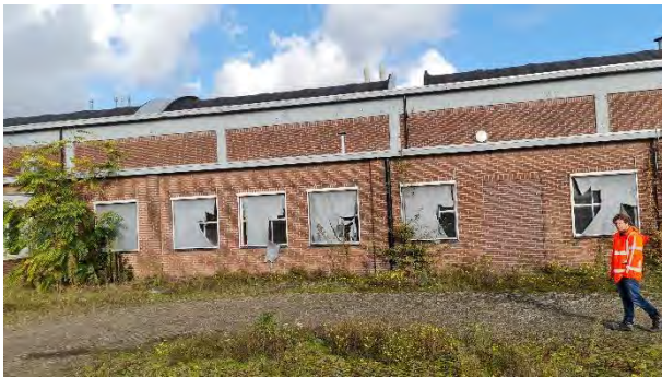
Buiten gebouw C
