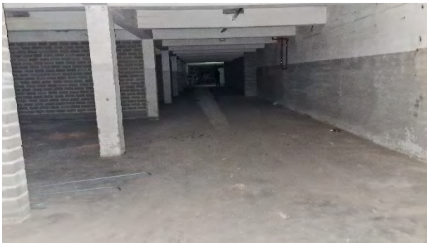
Binnen gebouw C - kelder
