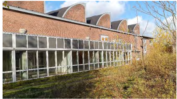
Buiten gebouw C
