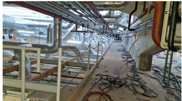
Binnen gebouw C
