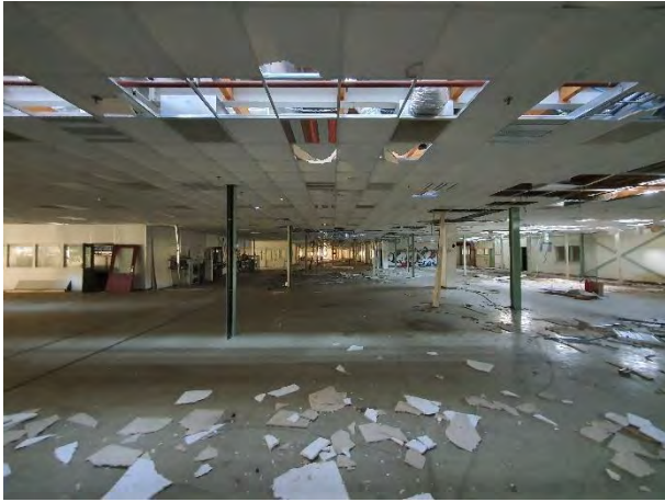
Binnen gebouw C
