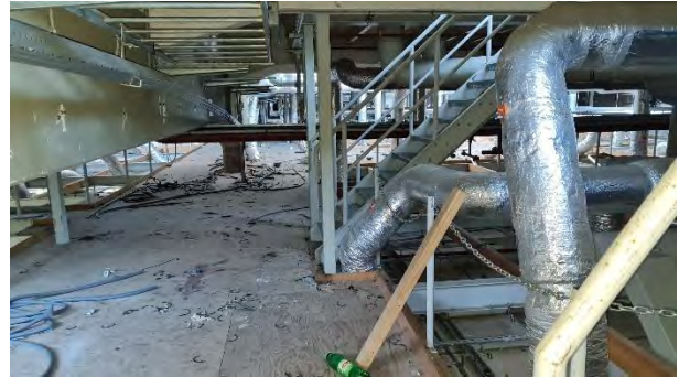
Binnen gebouw C
