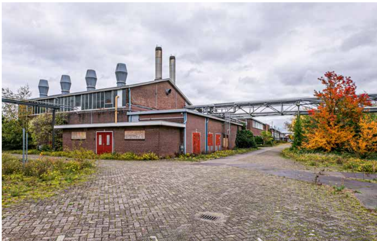
49. Ketelhuis aan centrale as op voormalig Philipsterrein, kijkend in oostelijke richting
