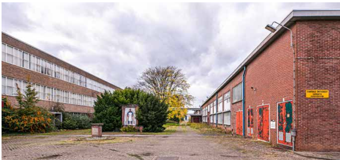
65. Centrale as huidige situatie, kijkend van oost naar west. Bron: Kim Roufs
