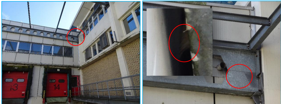
Foto's: Locatie van aangetroffen kerkuil roestlocatie, noordelijke laaddocks.
