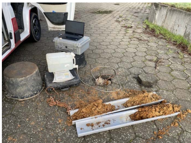
Foto 1: Overzicht opstelling INF 3
