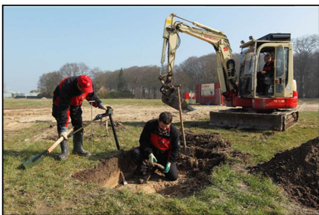
Figuur 10. Benaderen van een significant object m.b.v. een hydraulische graafmachine.
