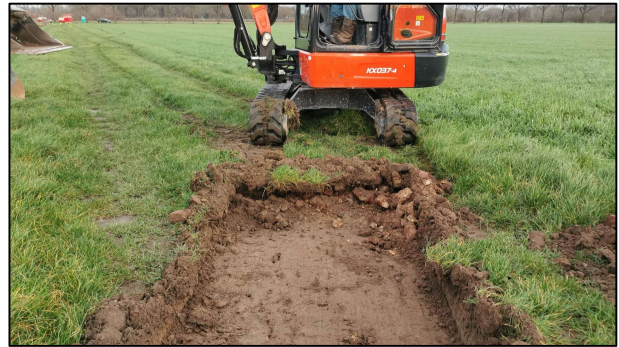
Foto 6 Ontgraven proefsleuven
