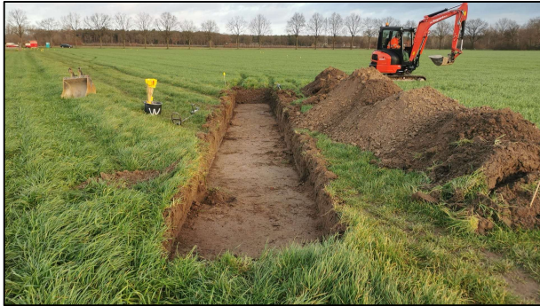
Foto 7 Ontgraven proefsleuven
