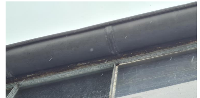
Figuur 6: Dakrand van zuidelijke gevel van opstal
