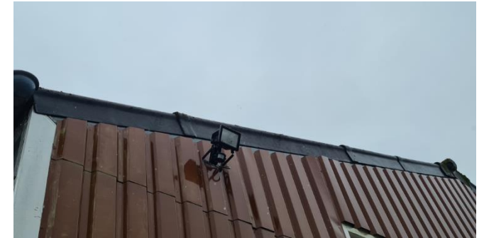
Figuur 5: Dakrand van westelijke gevel van opstal
