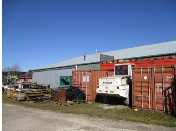
Afbeelding 3. Loods die binnen het plangebied gelegen is.
