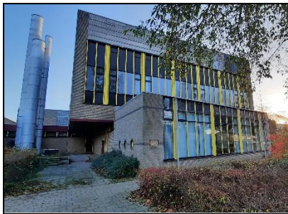
Figuur 3. Vooraanzicht schoolgebouw, kijkrichting oosten.
