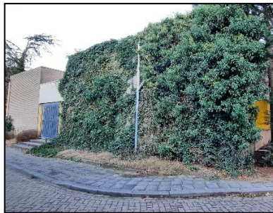
Figuur 4. Zijaanzicht schoolgebouw begroeid met klimop, kijkrichting noorden.
