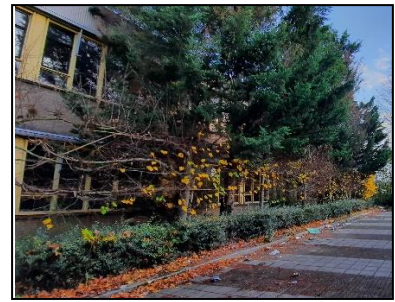
Figuur 5. Impressie deel onderzoekslocatie, kijkrichting noorden.
