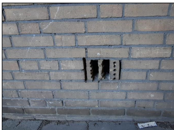
Figuur 19. Opening in gevel die toegang verleent tot spouwmuur.
