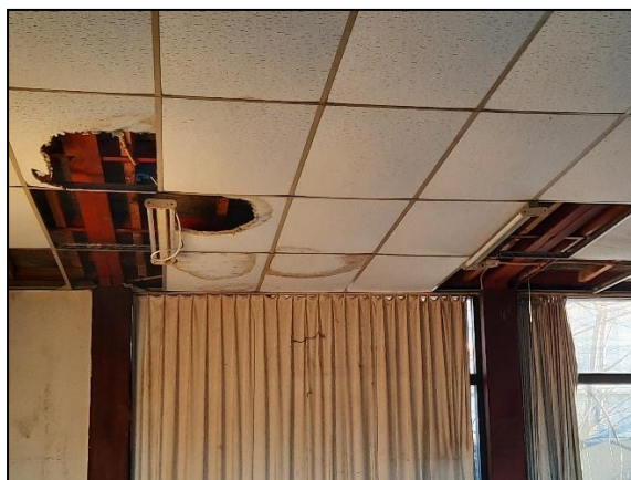
Figuur 17. Open systeemplafond in een van de bijgebouwen.
