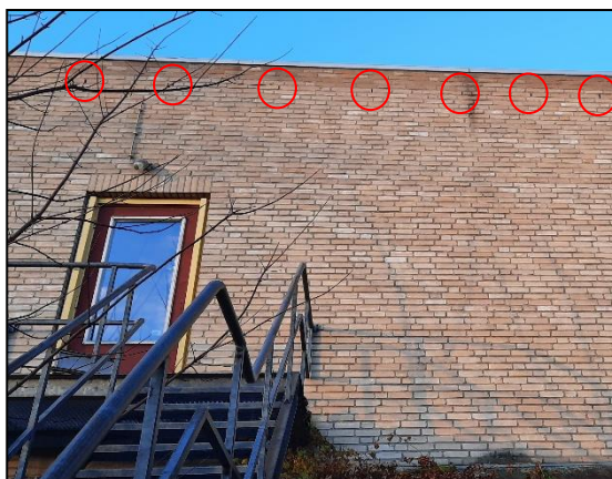
Figuur 16. Voorbeeld van stootvoegen (rood omcirkeld), kijkrichting westen.
