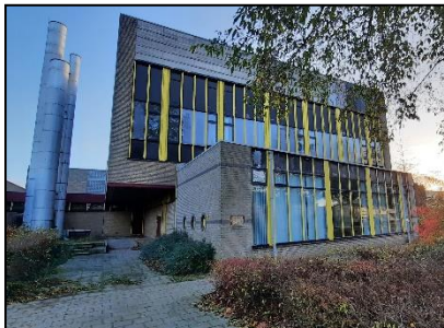
Figuur 3. Vooraanzicht schoolgebouw, kijkrichting oosten.
