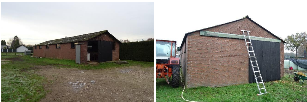
Afbeelding 3 en 4: Bestaande te slopen stal op de kavel. Bron: R.J.L. Bijvelds 10-12-2020
