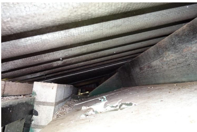
Afbeelding 9: Dak met grote tussenruimte tussen golfplaten en isolatieplaten. De aanwezigheid van vaste rust-, voortplantings- en verblijfplaatsen van huismussen is uitgesloten. Bron: R.J.L. Bijvelds Datum: 10-12-2020
