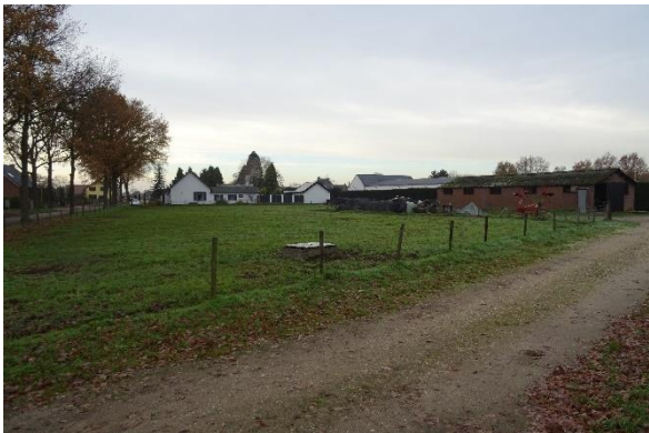
Afbeelding 6: Bestaande te slopen vervallen schuurtje/ schuilstal op de kavel. Bron: R.J.L. Bijvelds 10-12-2020
