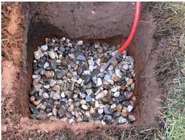
Grind toegevoegd en gat nat gemaakt volgens handleiding
