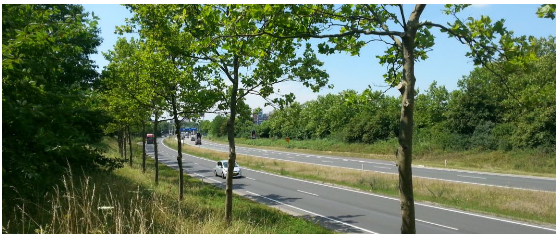
Foto 5. Impressie van de N280 waar deze wordt verruimd en een doorsteek wordt gemaakt naar de Schipperswal.
