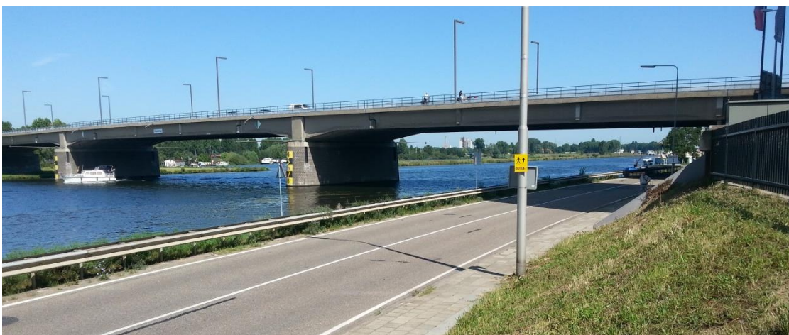
Foto 2. Impressie locatie aanpassing Looskade, ter hoogte van de onderdoorgang met de N280.
