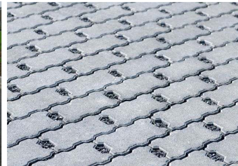
voorbeeld waterdoorlatende verharding
