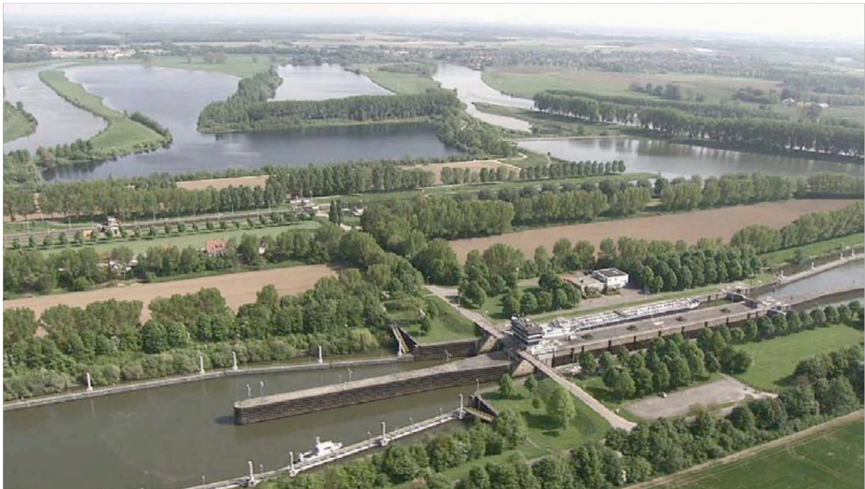
De Lus van Linne vanuit westelijke richting, met op de voorgrond het sluizencomplex Osen. Foto Rijkswaterstaat.
