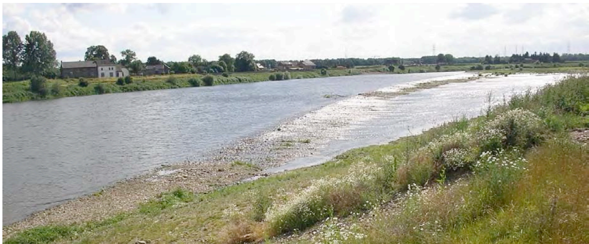
De Gerelingsplas wordt benedenstrooms verbonden met de Maas met een overstroombare, brede uitstroomdrempel. Deze drempel vormt een voor vissen en kanovaarders passeerbare toegang tot het achterliggende natuurgebied in de Lus van Linne. Op deze foto de lage instroomdrempel bij Meers langs de Grensmaas. Foto: Jan Jaap Tiemersma.
