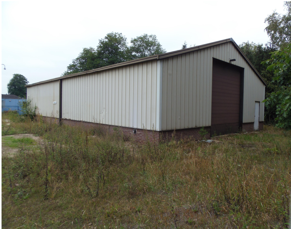
Figuur 6. Te slopen, uit metaal opgetrokken loods.
