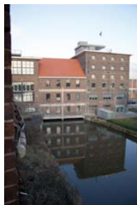
kantorenvleugel van de ECI.
