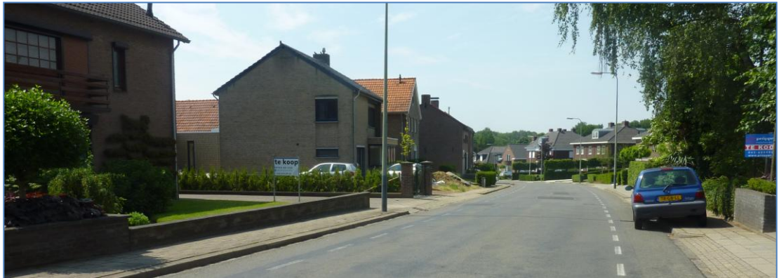
Op de Bies ter hoogte van het plangebied richting kern Schimmert
