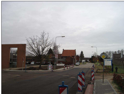
Groot Haasdal gezien in noordoostelijke richting, met de entree van De Steeg aan de linkerzijde.
