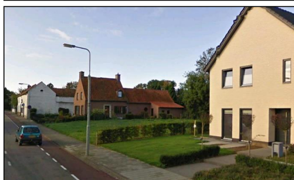
Foto's bestaande situatie (van boven naar beneden: komend vanuit zuidelijke richting)
