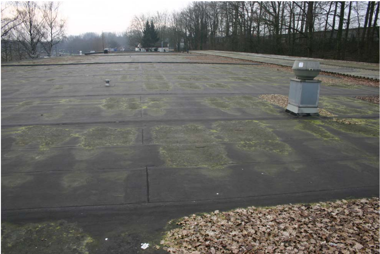
Figuur 4.2.2. Ook op het dak zijn geen openingen aanwezig die dieren toegang tot het gebouw verlenen.
