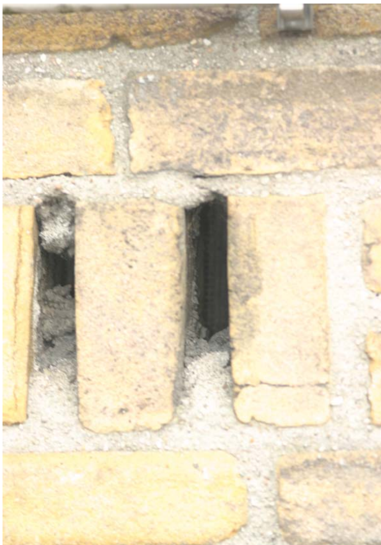
Figuur 4.2.1. De open stootvoegen aan de zuidoostzijde zijn vanaf de spouwzijde voorzien van een metalen rooster (vaag zichtbaar in de rechter open stootvoeg).
