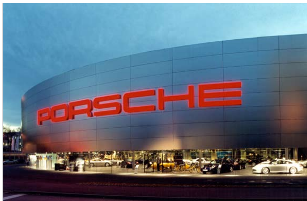
uitgesproken reclame in gevelvlak
