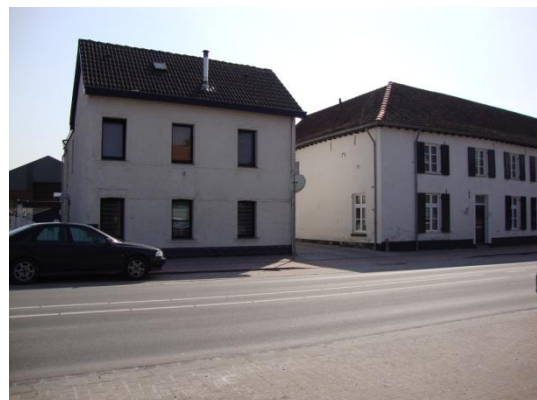
De bebouwing ten noorden van de projectlocatie, met aan de rechterzijde Hunnecum 17
