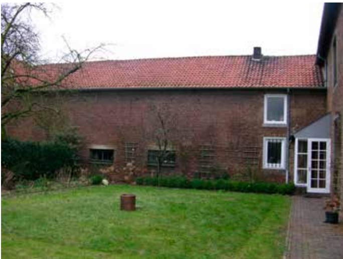
4. De zuidkant met nieuwe vensters in de keuken en stalramen uit de periode na 1942
