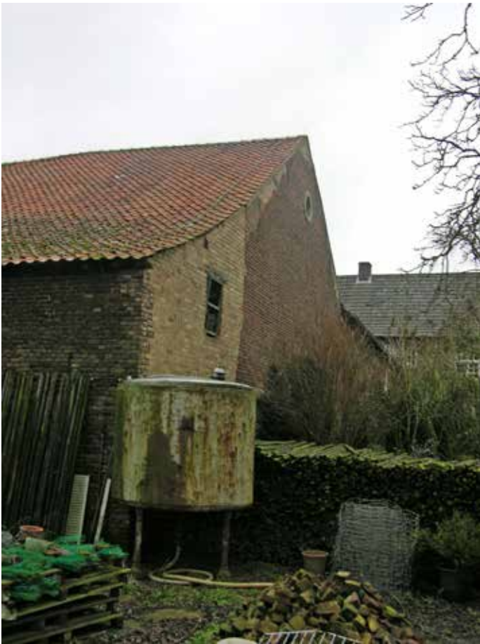
6. De schuur is naar achter uitgebouwd
