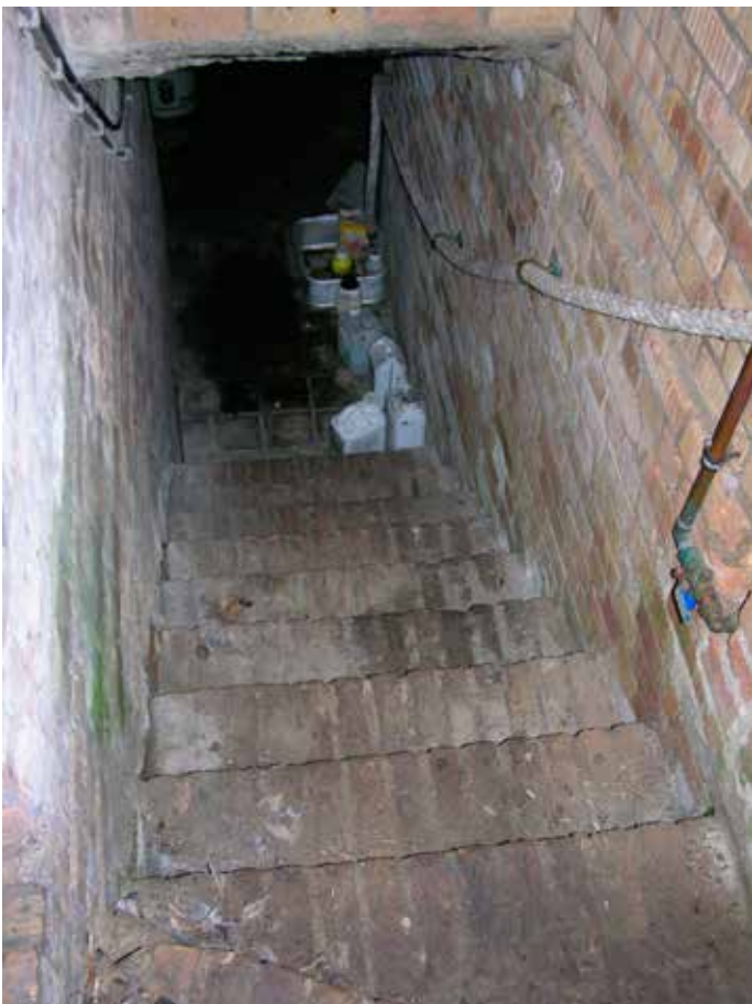
12. De trap naar de kelder
