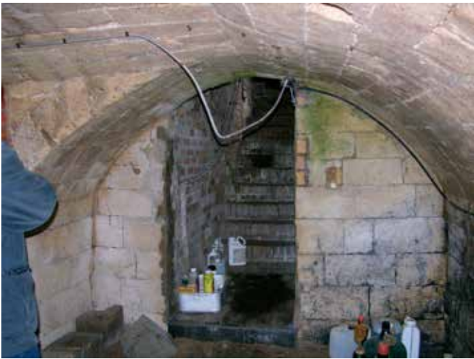
14. ....en de tegenkant met de nieuwe trap. De eindwand staat op de grens van de stal
