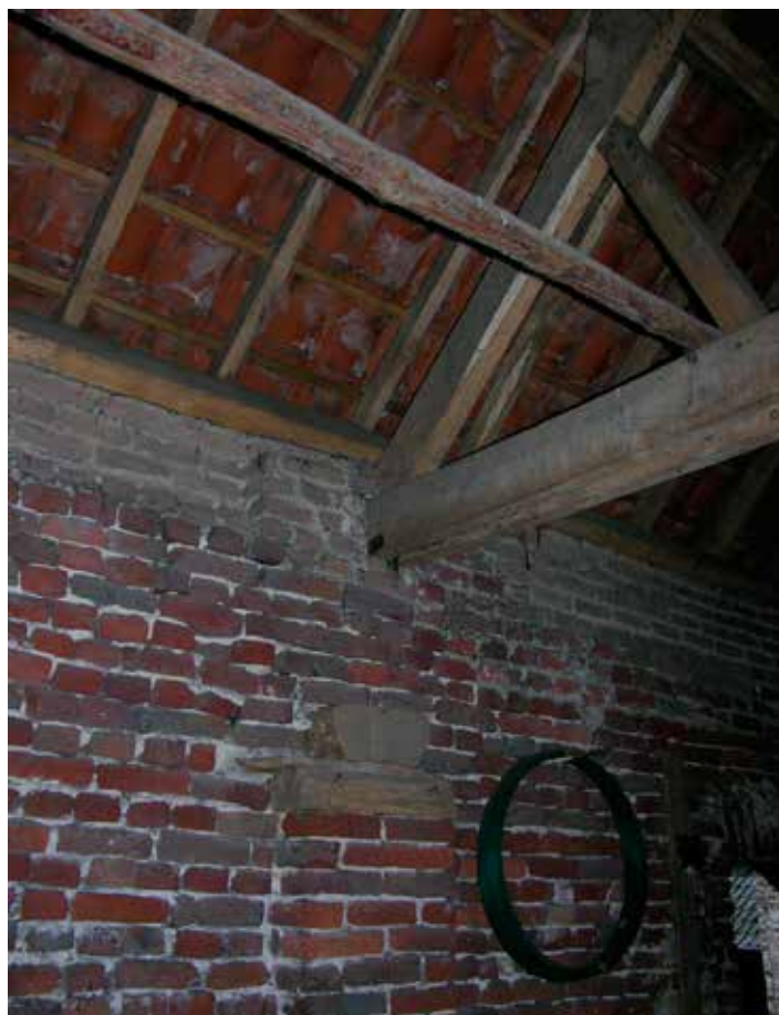
19. De kap van na 1942, met de ophoging van de muur
