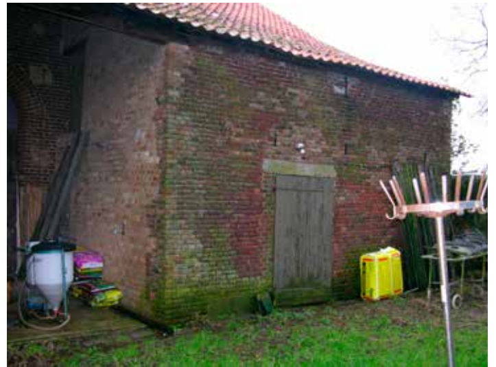
7. In de aanbouw zit een deur die toegang geeft tot de hele stalvleugel
