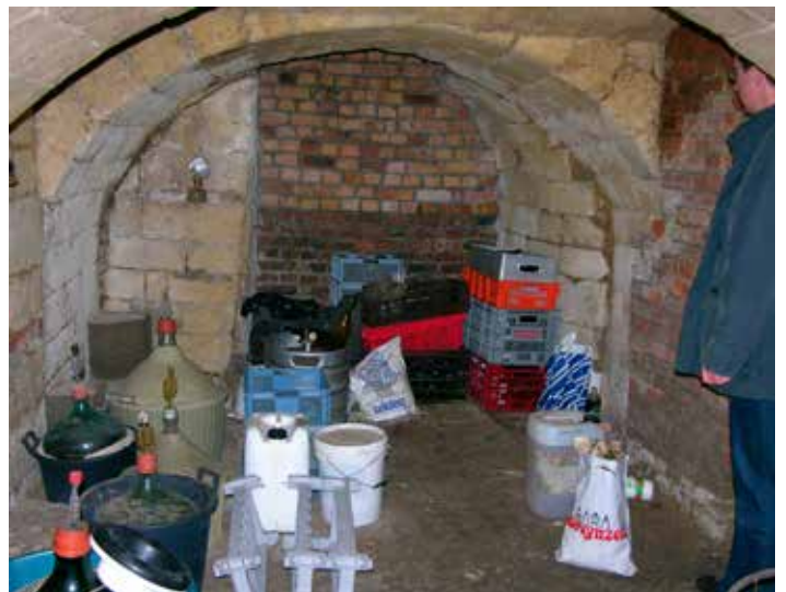
17. De kopse wand van de kelder, onder de hoek van de schuur. Vandaar de versteviging
