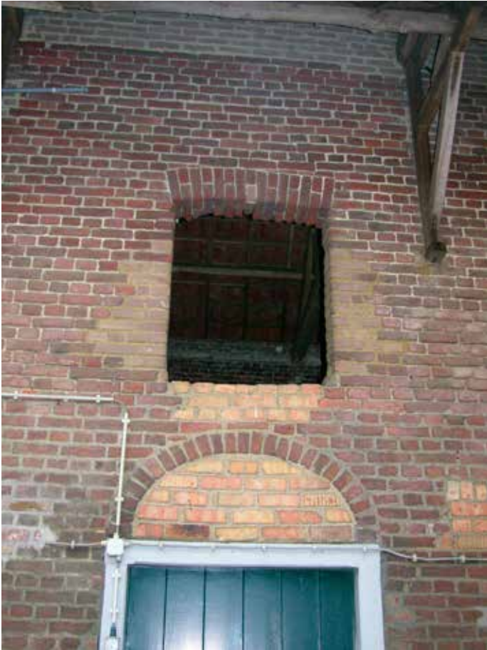
2. Een van de oorspronkelijke openingen naar de zolder, met daarboven de opgehoogde muur na de brand uit 1942, en de vernieuwde kap
