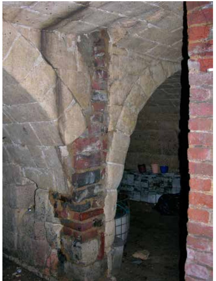
15. De verbinding met de tweede kelder, secundair ingebroken
