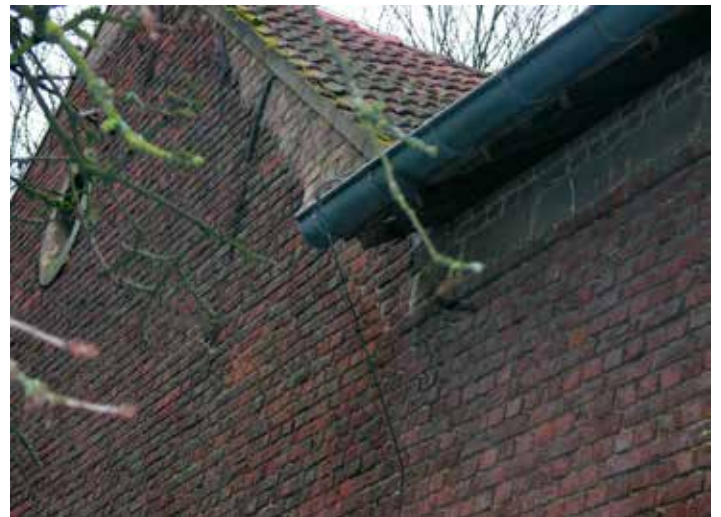
5. De opgehoogde muur end e aansluiting op het dak van de schuur dat ook is opgehoogd
