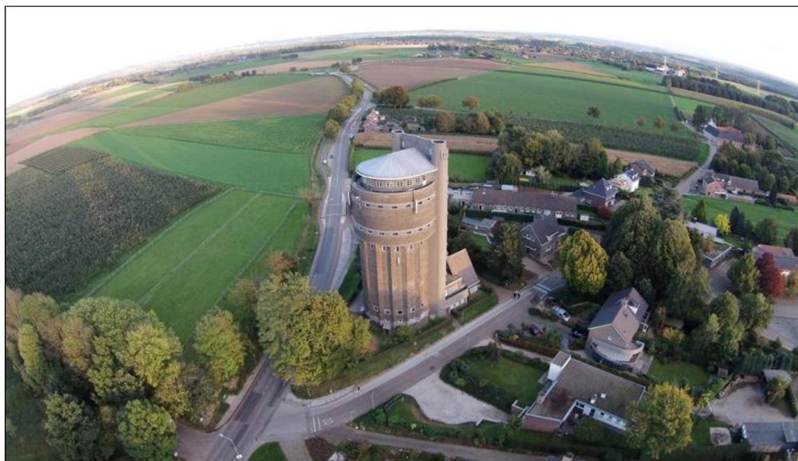
Zicht naar het zuidoosten met op de voorgrond de bestaande watertoren met aangrenzende woning.
