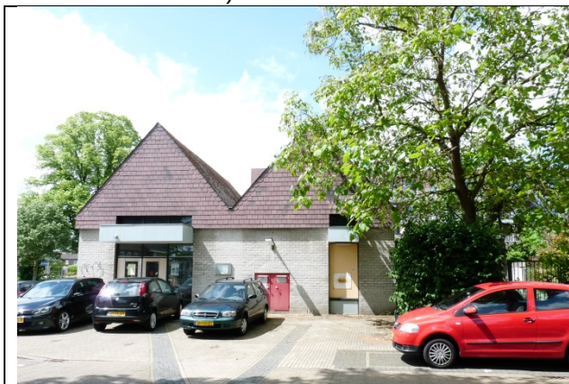
Fig. 3. Overzicht plangebied. Voorgevel voormalig postkantoor. Foto genomen richting het zuidwesten
