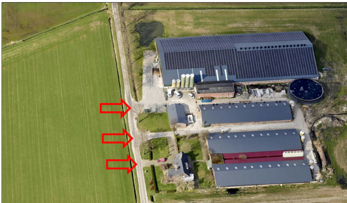
Impressie bestaande situatie plangebied met aanduiding ontsluitingen (drone-opname d.d. 26 maart 2021)
