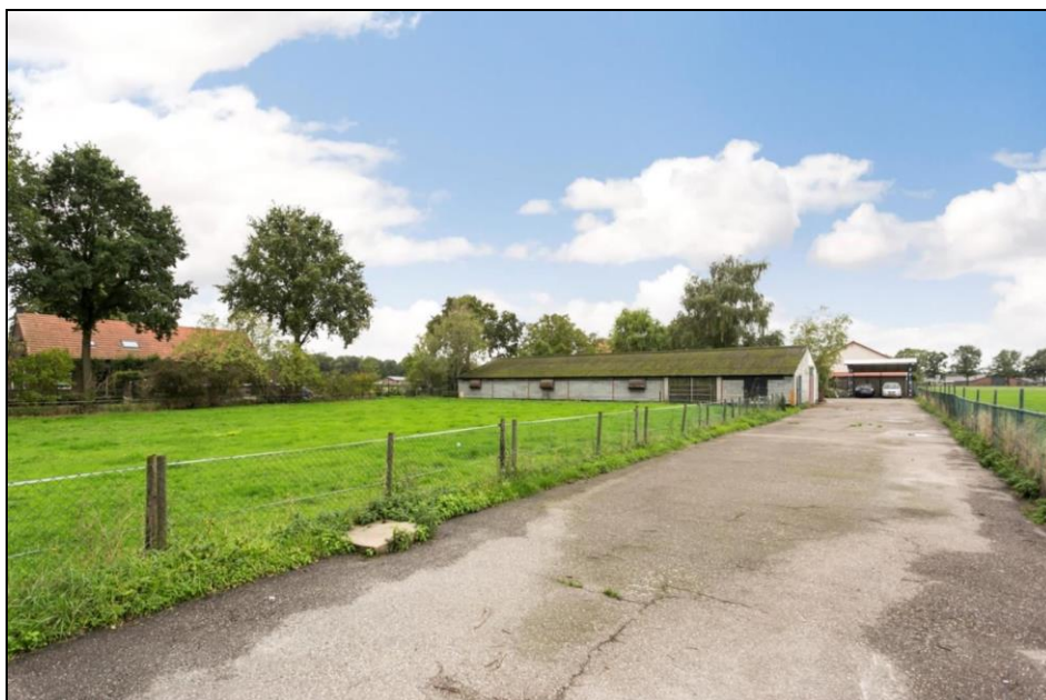
Figuur 5: Voormalige pluimveestal en erfverharding ten oosten van de huidige bedrijfswoning
