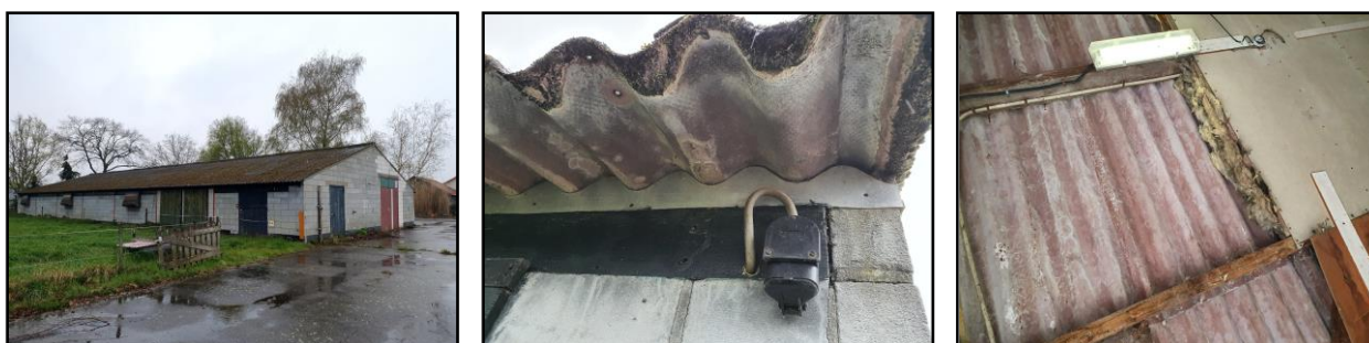
Zicht op het noordelijke te slopen deel van de kippenstal, de afgedichte golfplaten met vogelschroot en het dak aan de binnenzijde te slopen staldeel.
