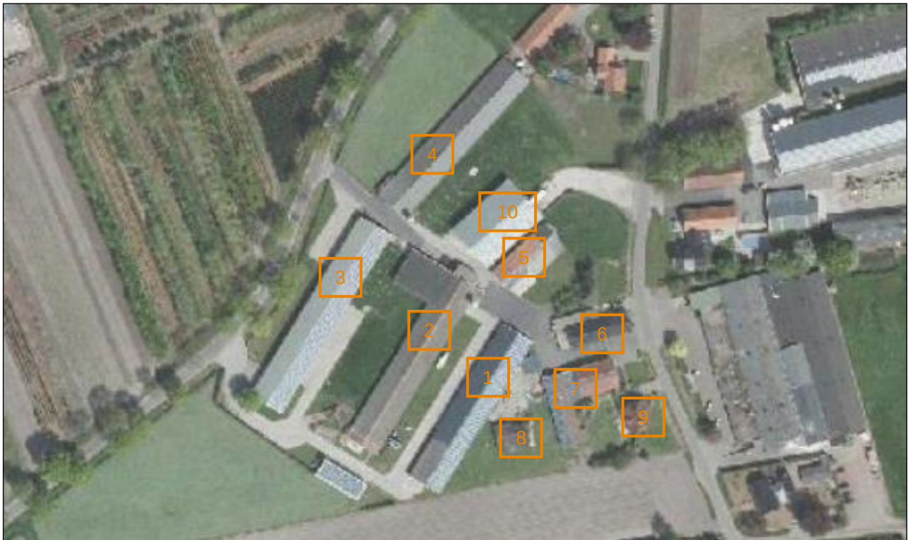
Figuur 2: Overzicht bestaande gebouwen
