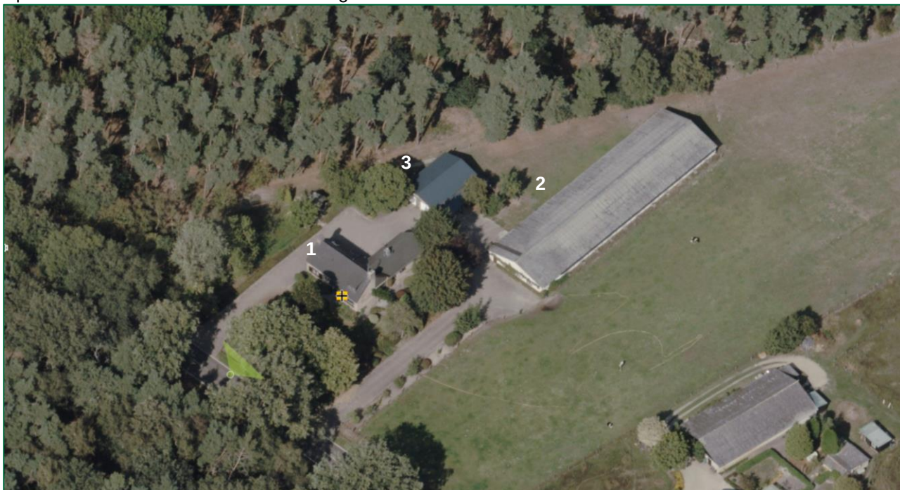
Figuur 3: Huidige situatie (bron: streetsmart.cyclomedia.com)
