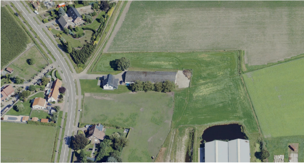
Obliëk luchtbeeld | zichthoek vanuit westen - Cyclomedia
