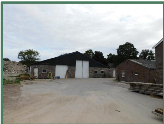
Foto 7: Resterend deel gesloopte stal (links) en te behouden halfopen schuren (rechts).
