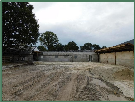
Foto 3: Overzicht oostelijke stal, gesloopt deel en resterend deel.
