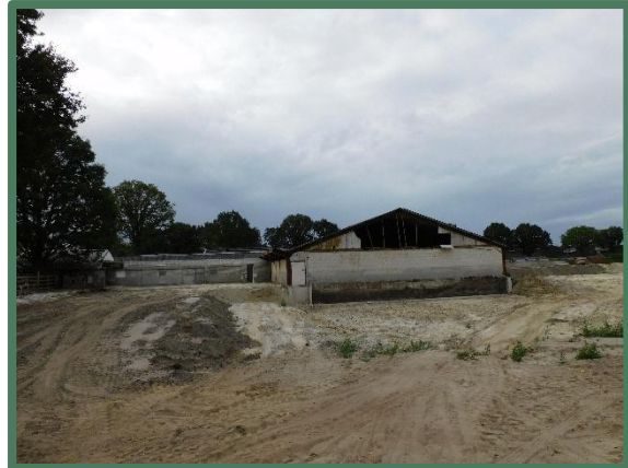
Foto 4: Overzicht oostelijke stal, gesloopt deel en resterend deel.
