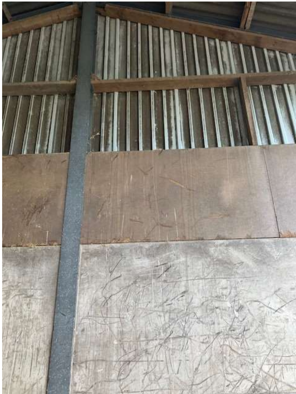
• Afbeelding 12: binnenzijde stal 3, ongeïsoleerde damwand en ongeïsoleerd dak
