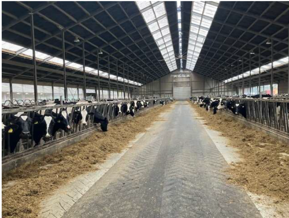
• Afbeelding 21: binnenzijde stal 3, ongeïsoleerd dak met lichtstraat en licht doortatende golfplaten
