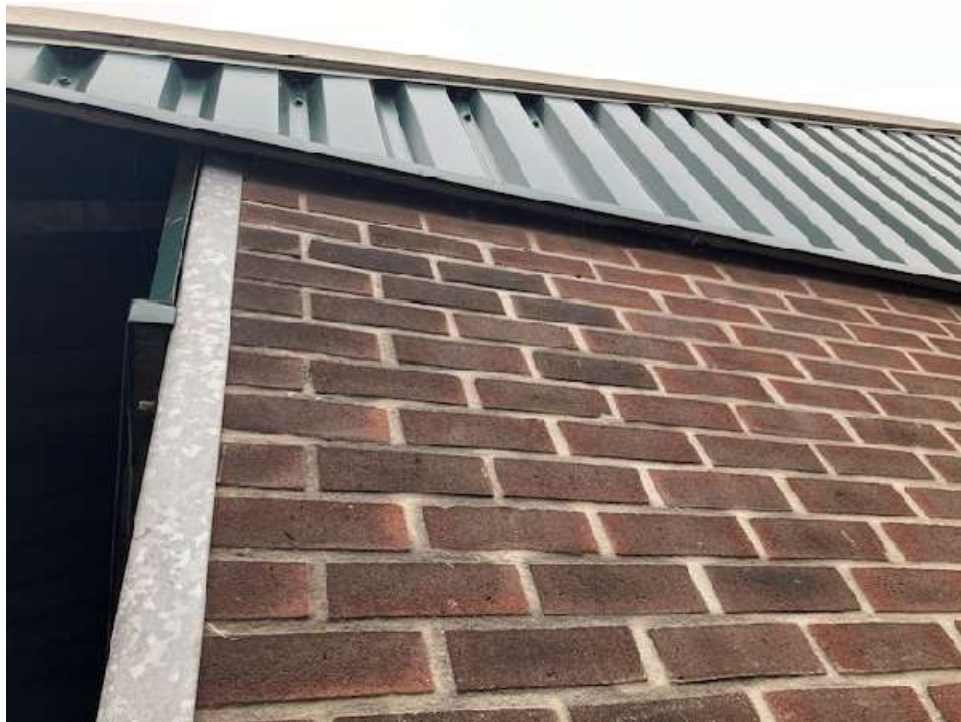
• Afbeelding 19: Detail aansluiting metselwerk op damwand
