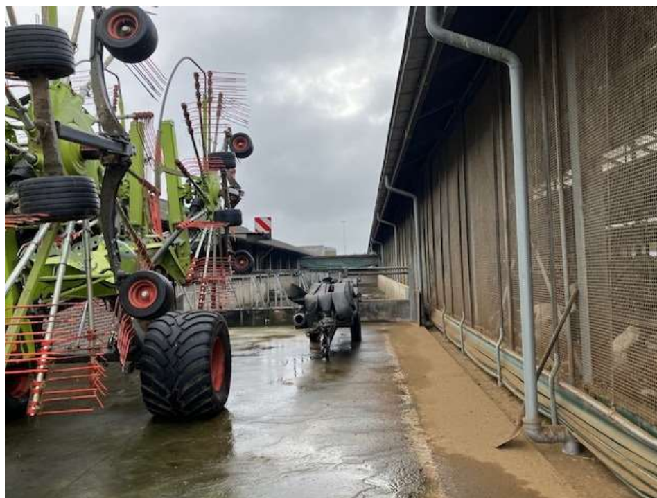
• Afbeelding 7: ruimte tussen de stallen 2 en 3, rechts de gevel van stal 3 bestaande uit windbreekgaas
