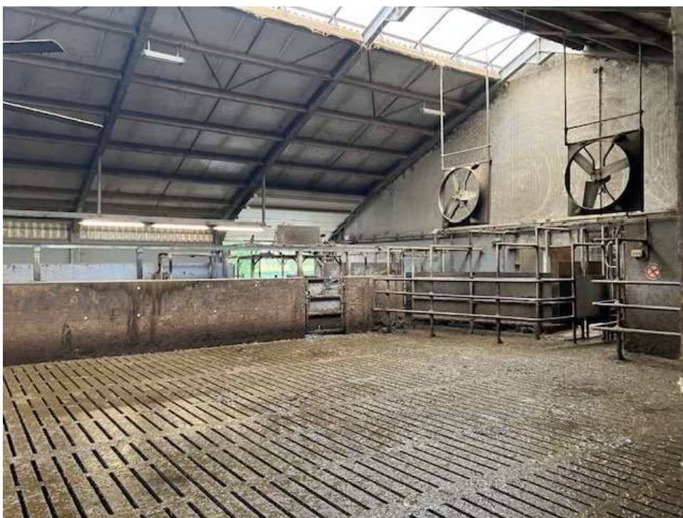
• Afbeelding 24: binnenzijde stal 1 (wachtruimte)
