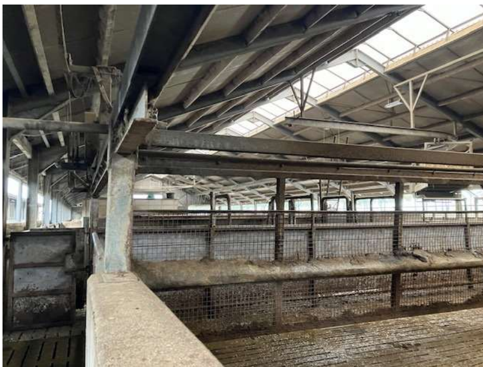
• Afbeelding 23: binnenzijde stal 1 (wachtruimte)
