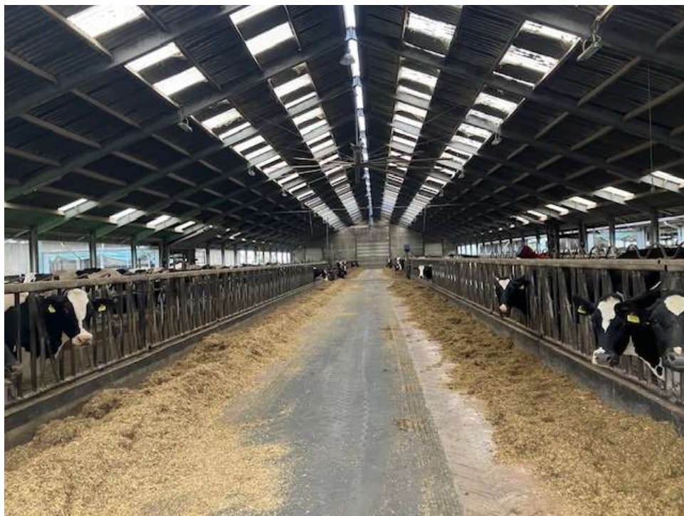
• Afbeelding 20: binnenzijde stal 2, ongeïsoleerd dak met licht doorlatende golfplaten
