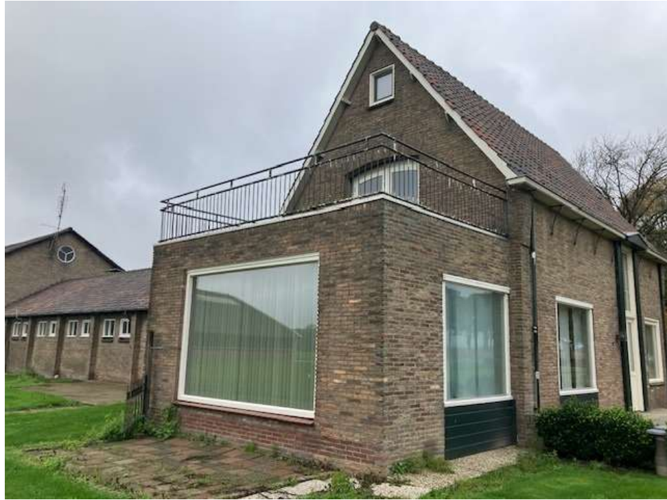
• Afbeelding 5: linker zijgevel woonhuis
