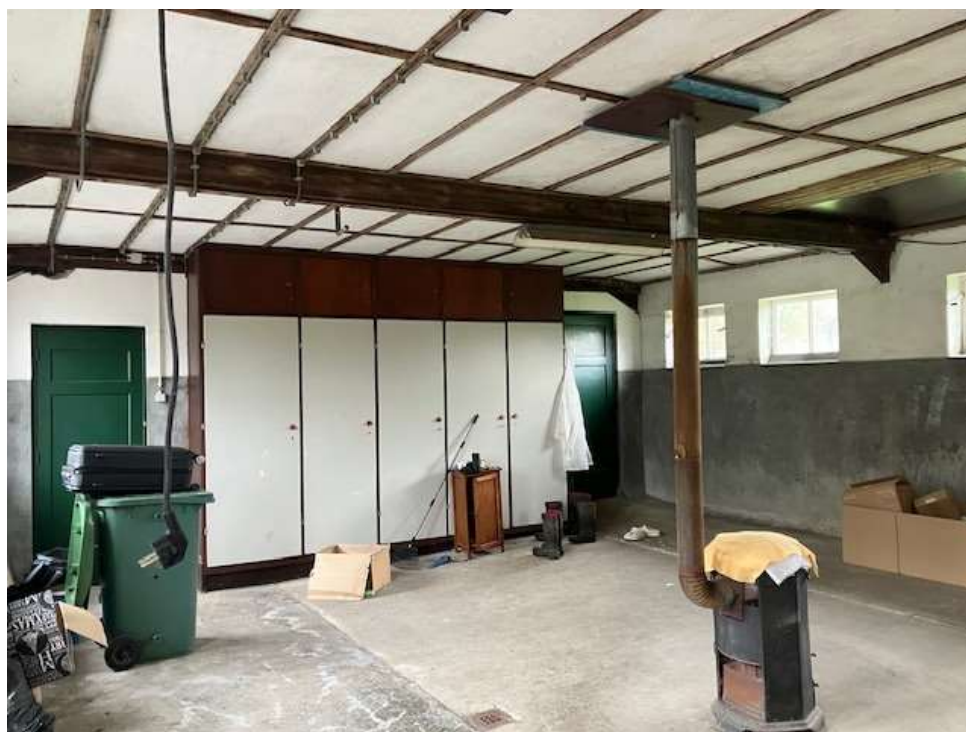
• Afbeelding 11: binnenzijde te slopen schuur
