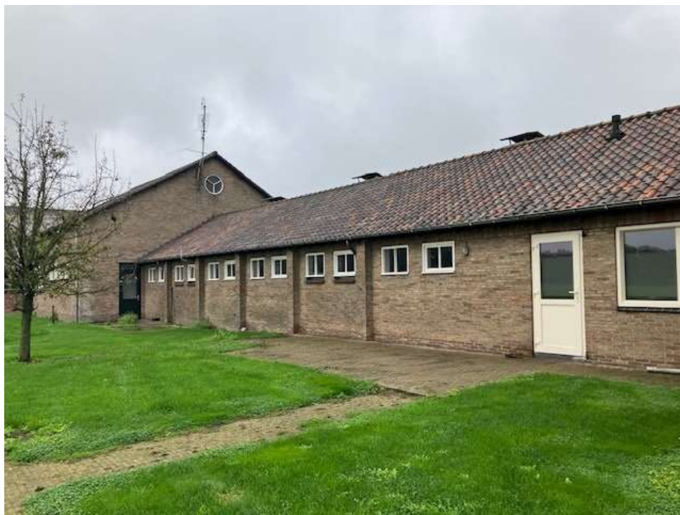
• Afbeelding 7: aangebouwde schuur, wordt gesloopt, hoge schuur erachter blijft behouden
