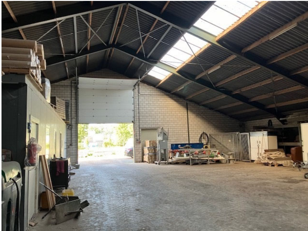
• Afbeelding 19: opslagloods in de te slopen pluimveestal
