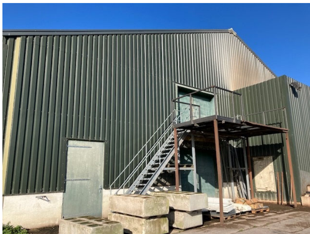
• Afbeelding 22: Achtergevel te slopen pluimveestal
