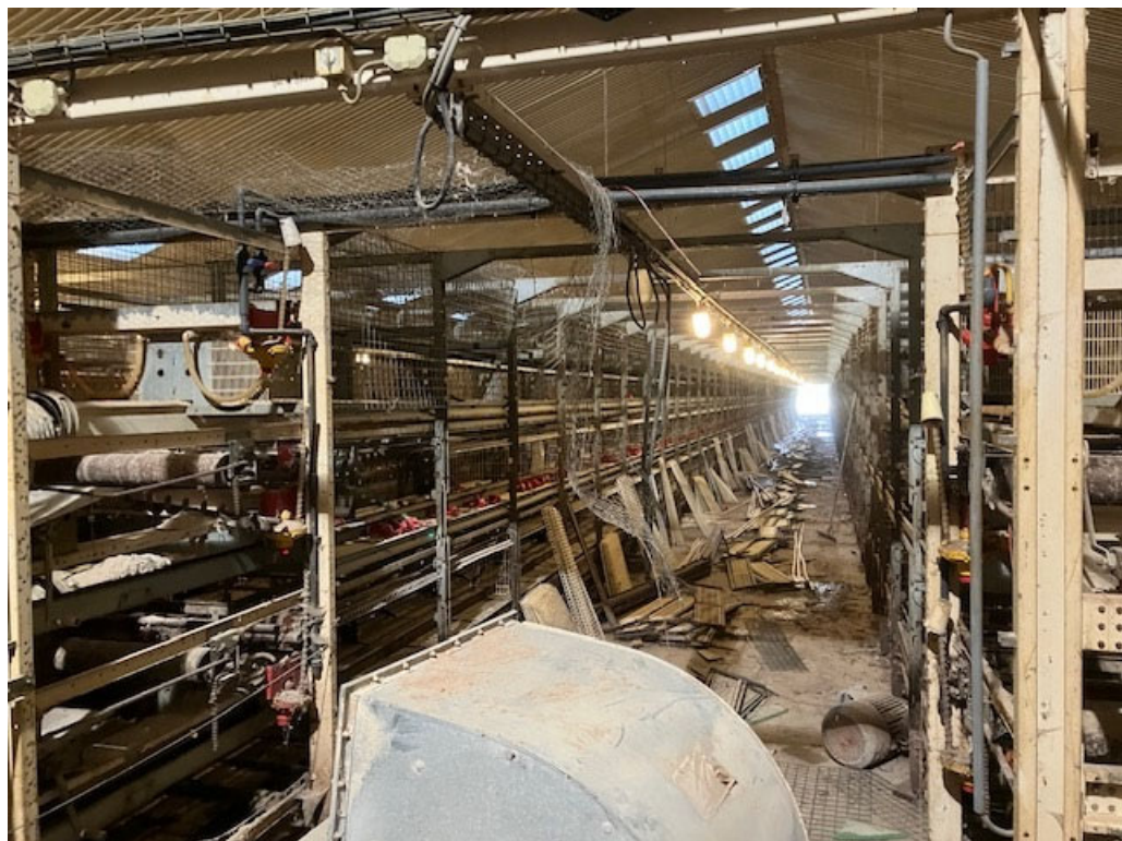
• Afbeelding 20: binnenzijde te slopen pluimveestal
