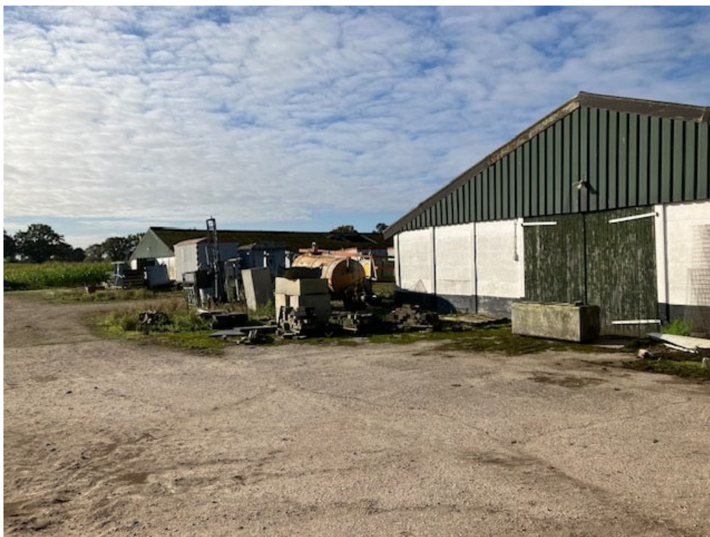
• Afbeelding 21: Achterzijde te slopen voormalige varkensstallen met erf
