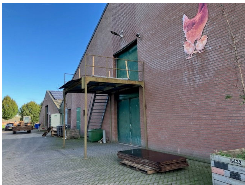
• Afbeelding 16: Voorgevel te slopen pluimveestal
