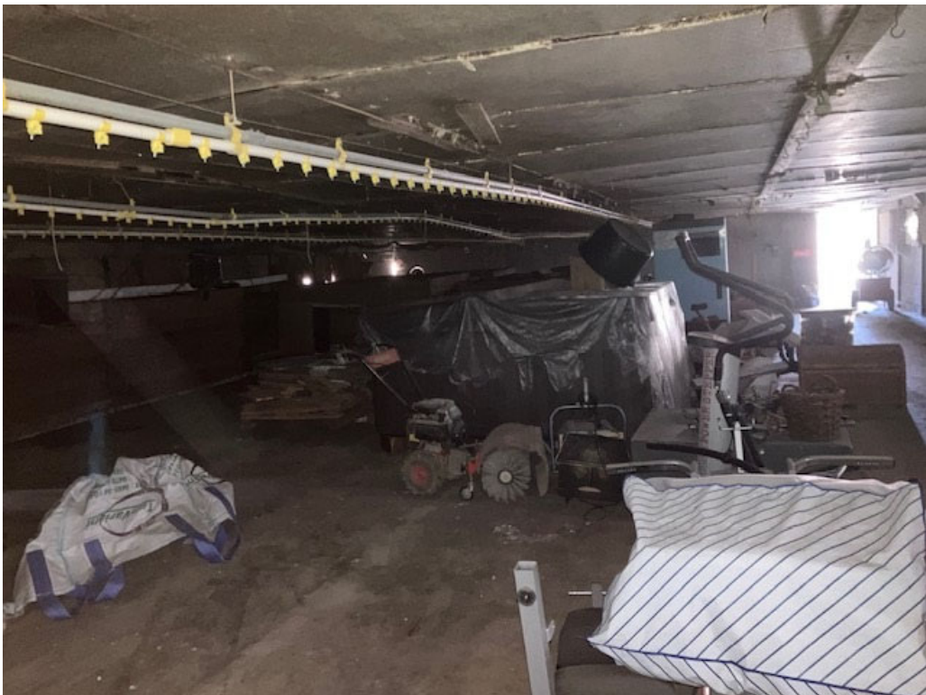
• Afbeelding 14: binnenzijde voormalige varkensstal
