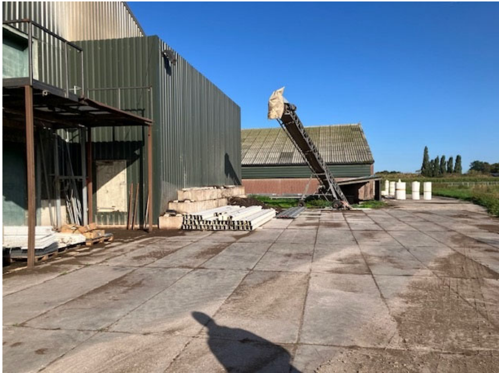
• Afbeelding 23: Achterzijde te slopen pluimveestal
