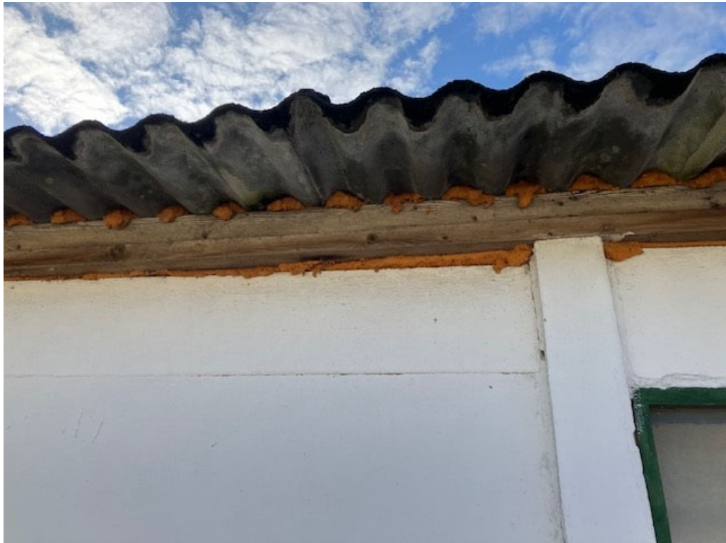
• Afbeelding 13: pur onder golfplaten om vogels te weren
