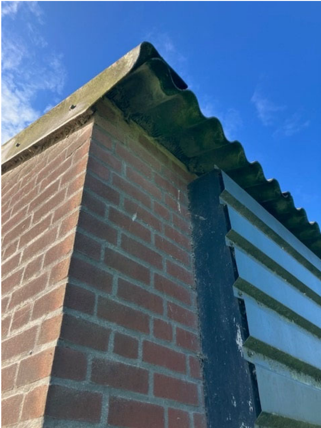
• Afbeelding 26: vogelschroot op de muurplaat
