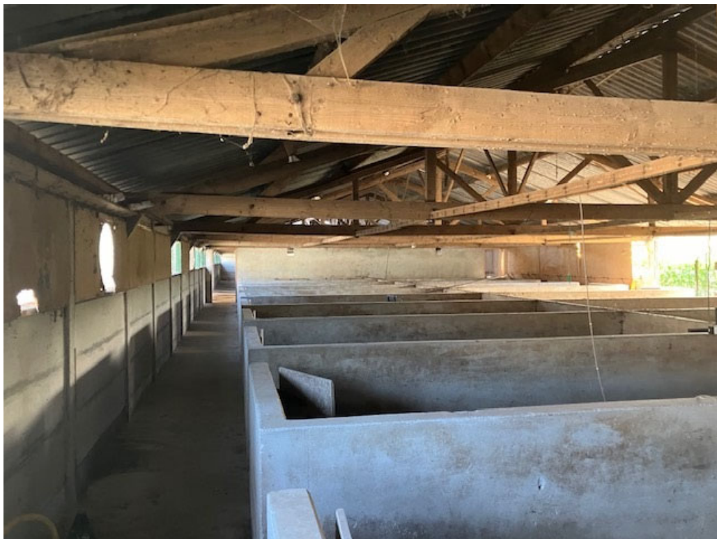
• Afbeelding 6: Binnenzijde voormalige varkensstal
