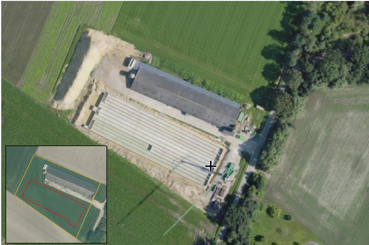
Figuur 2.1.1: Luchtfoto huidige situatie Rosselsweg 9 (bron: streetsmart.cyclomedia.com)
