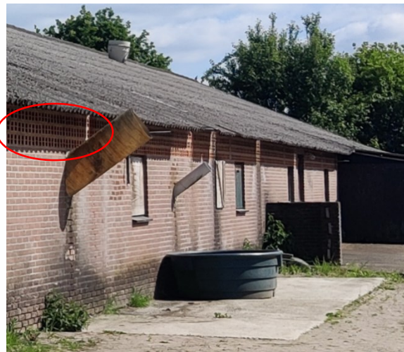
Figuur 4.1.2: Oostelijke schuur voorzien van luchtgaten en geperforeerde muur
