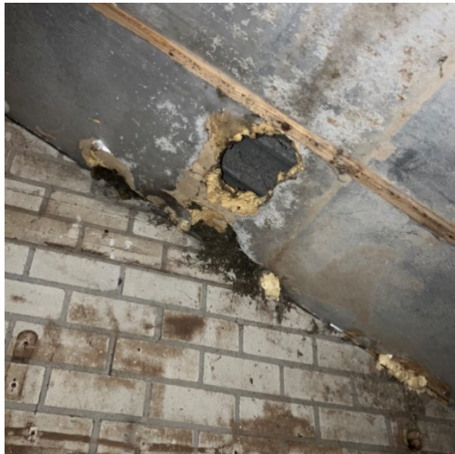
Figuur 4.1.1: Plafondisolatie in oostelijke stal
