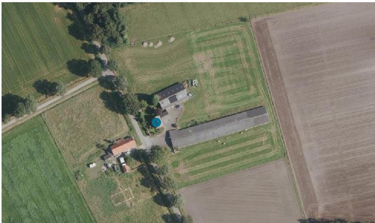
Figuur 2.1.1: luchtfoto van het plangebied (bron: pdok.nl/viewer)
