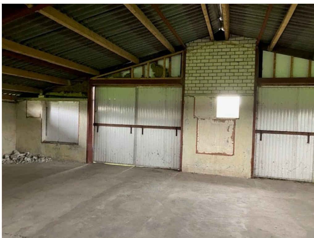
• Afbeelding 8: eindhevel, beplating van topgevel verwijderd
