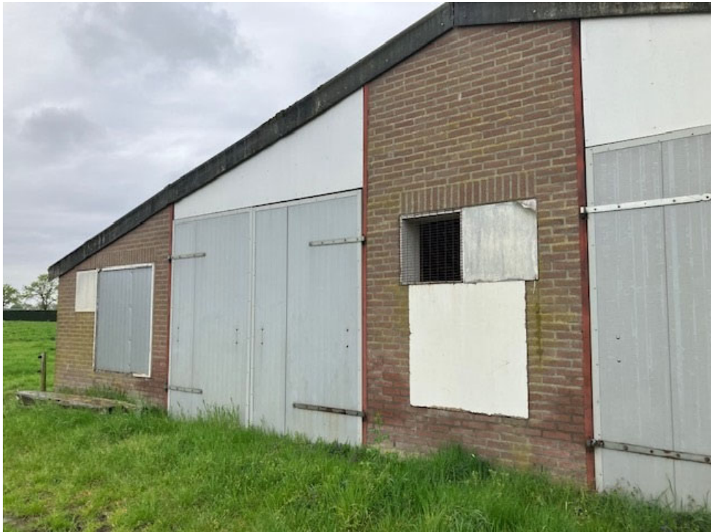
• Afbeelding 9: achtergevel, gaas in raamopening
