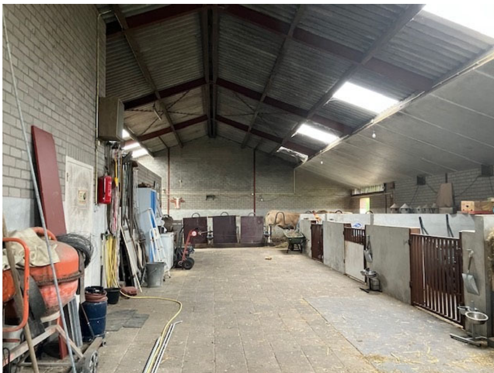
• Afbeelding 13: binnenzijde te behouden bijgebouw, in gebruik tbv rundvee
