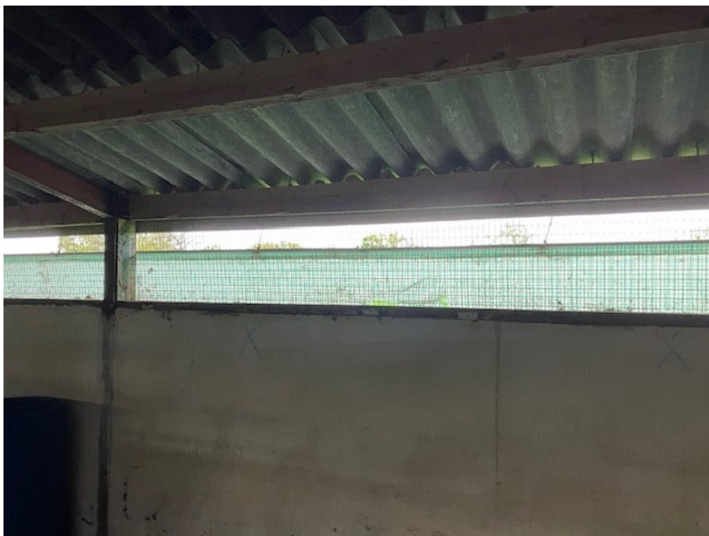
• Afbeelding 7: gaas in de luchtinlaat en vogelschroot onder de golfplaten
