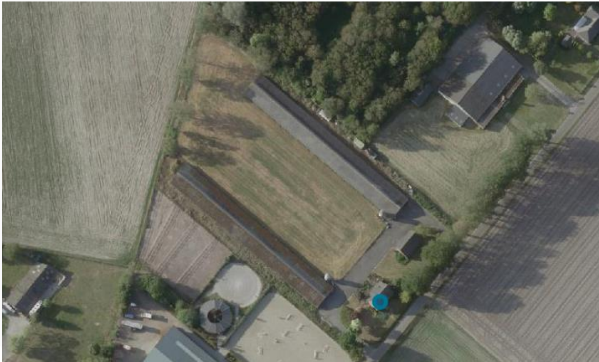
Figuur 2.1.1: luchtfoto van het plangebied (bron: pdok.nl/viewer)
