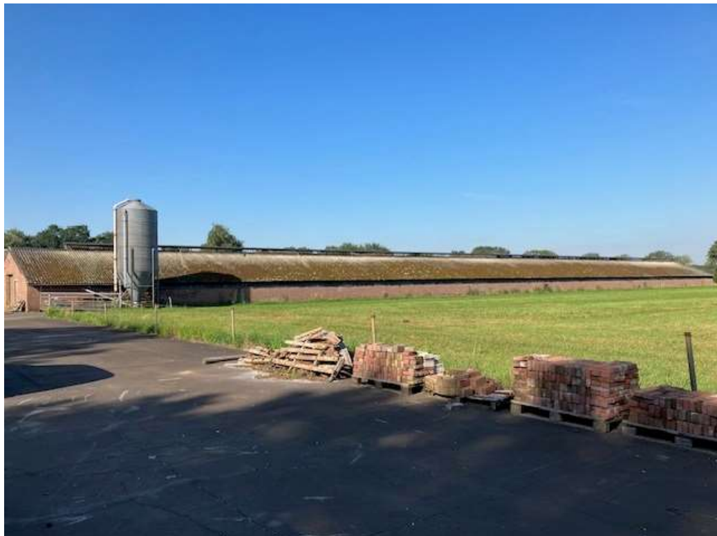
• Afbeelding 4: Te slopen stal
