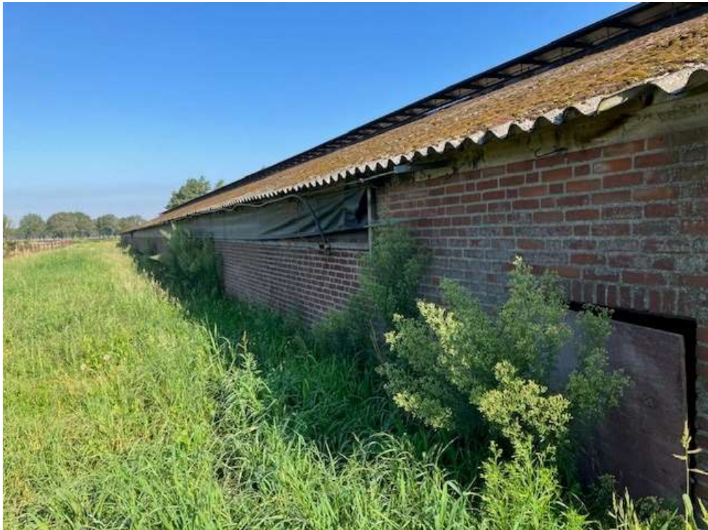
• Afbeelding 5: Zijgevel te slopen stal, golfplaten dak zonder dakgoot
